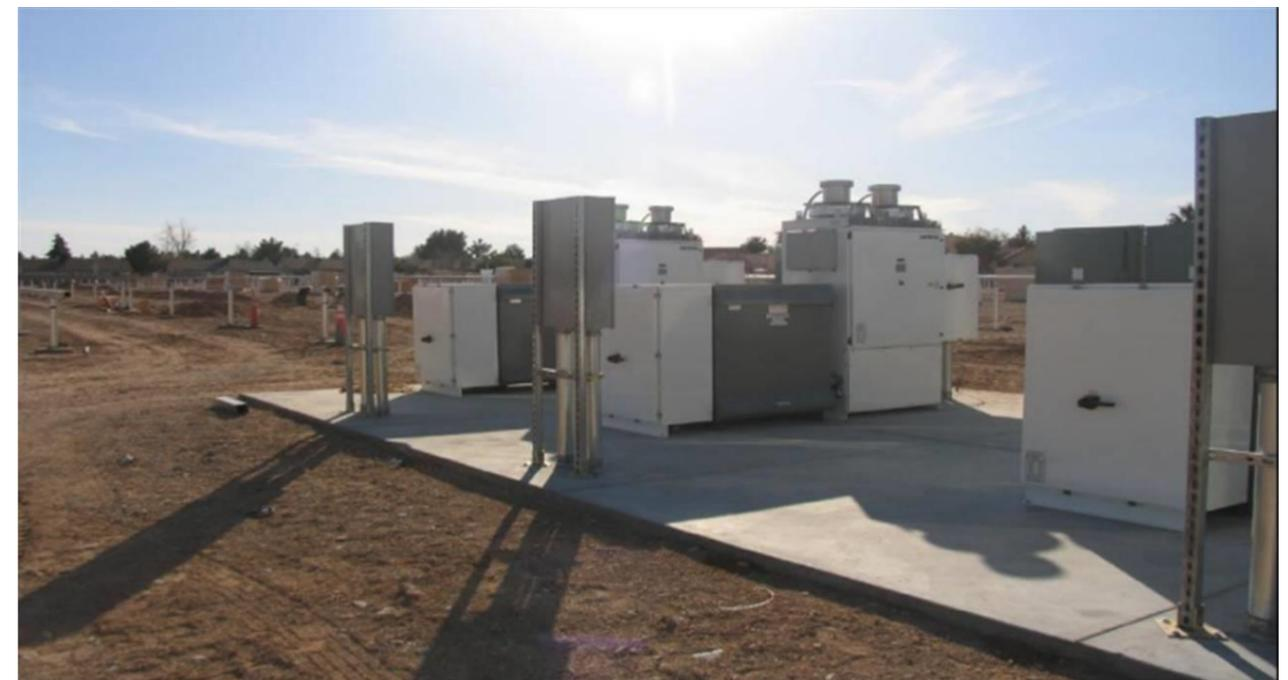
Figure 14 : exemple de plateforme onduleurs et transformateurs (Source : Sunpower, 2011)
