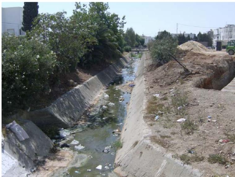
**Figure 24: Ancien lit de l'oued Bardo longéant le quartier des officiers à Khaznadar et à droite l'amorce de la déviation dans les dalots sous remblai**
