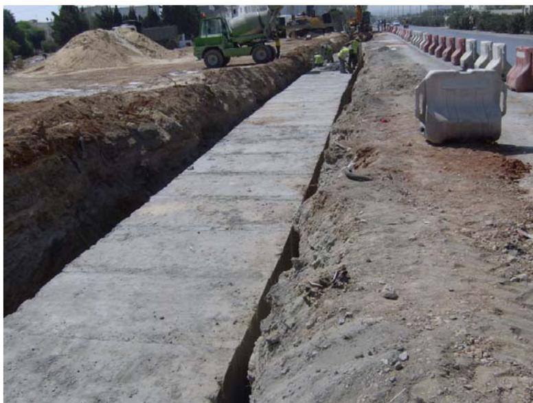
**Figure 25: Travaux de la nouvelle section de rive gauche du dalot assurant la déviation d'oued Bardo le long du boulevard du 7 novembre**
