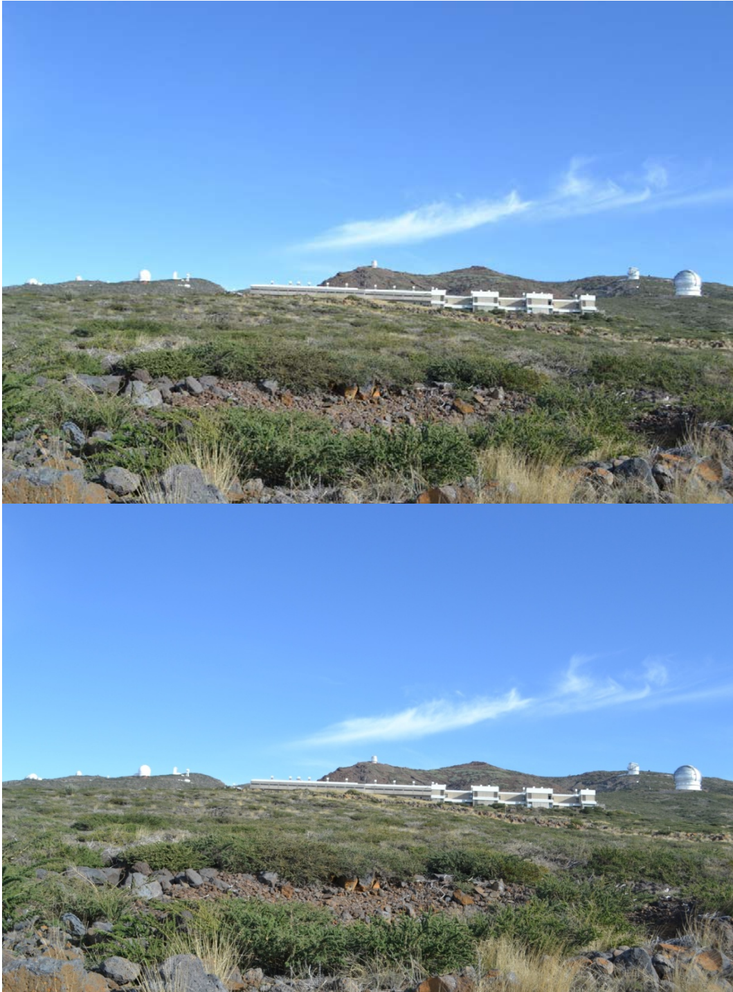
Fig. 56. – Implantación y estado actual del área de acopio en la alternativa M1
