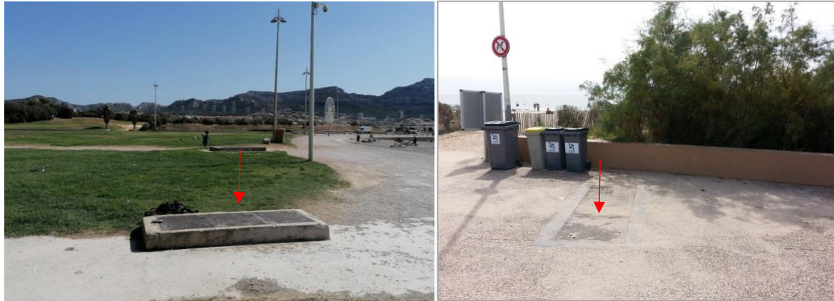
Figure 10 : Vues extérieures de deux chambres-plages (photos setec in vivo)
