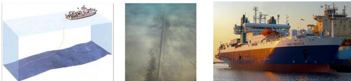
Figure 8 : Illustrations d'une pose de câble, d'un câble sur le fond et d'un navire câblé
