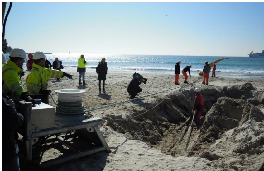
Figure 19: Operation de tirage du câble avec un cabestan hydraulique (setec in vivo)
