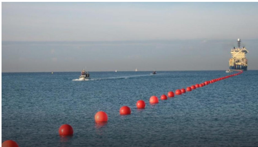
Figure 18 : Exemple de tirage d'un câble depuis un navire câblé vers la plage (ASN)
