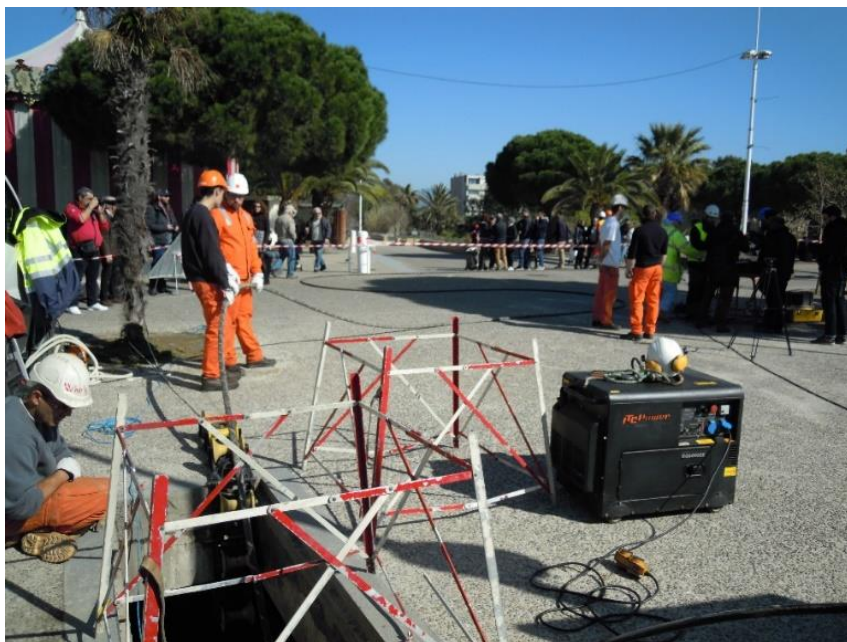
Figure 20 : Tirage du câble en dehors de la chambre-plage avant raccordement (setec in vivo)
