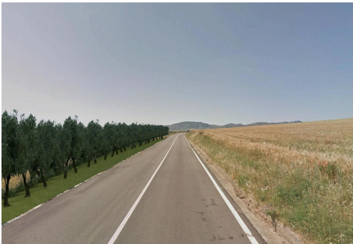
Vista 4 – stato post-opera
