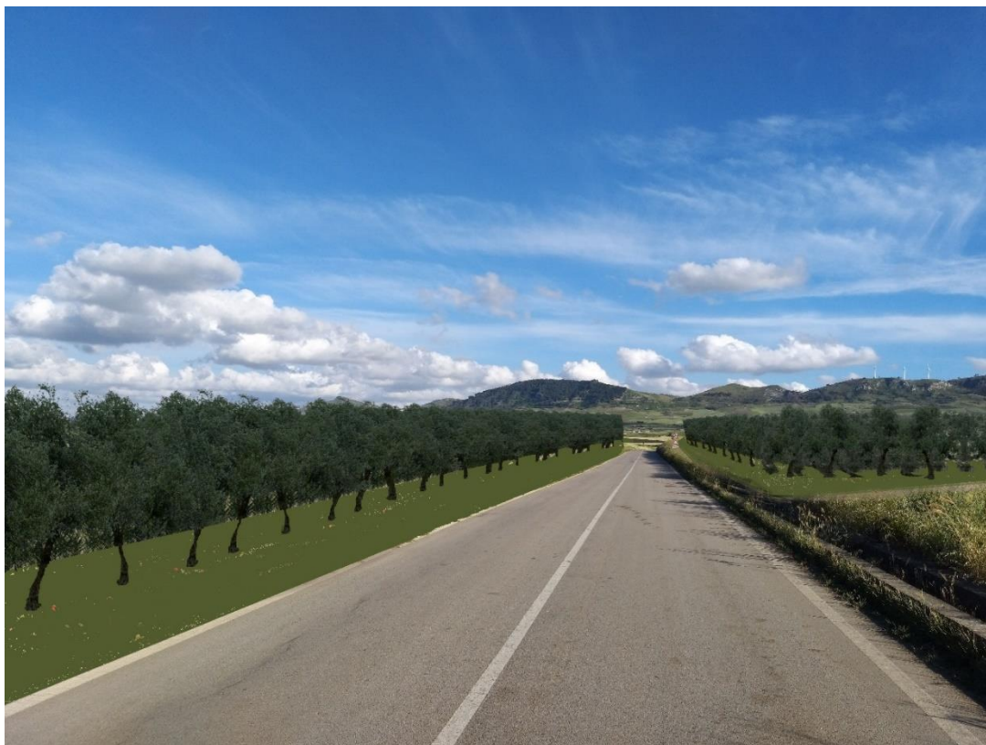
Vista 1 – stato post-opera
