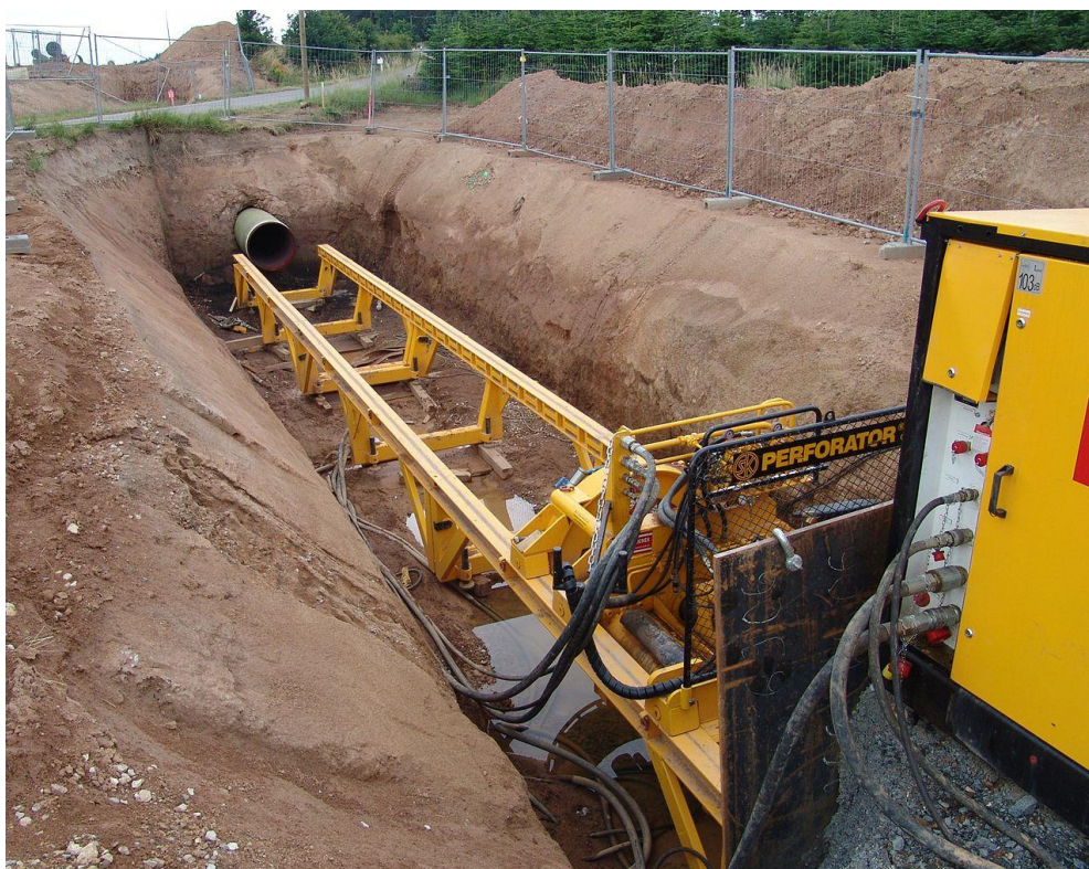
Fig. 145 - Esempio di tecnologia no dig per la posa di tubazioni
