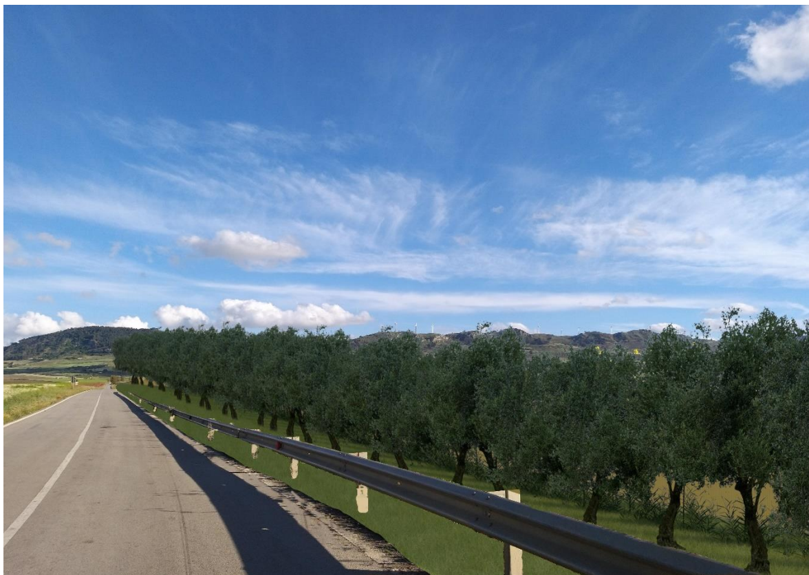
Vista 3 – stato post-opera
