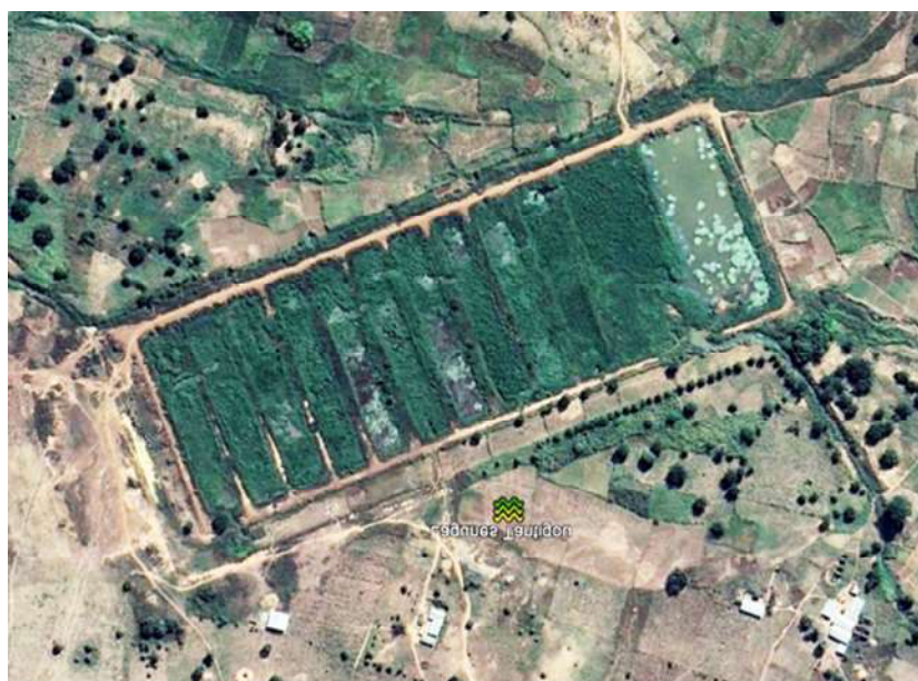
Figure 5-5 : Vue aérienne des lagunes de Tantigou en fin de saison des pluies
