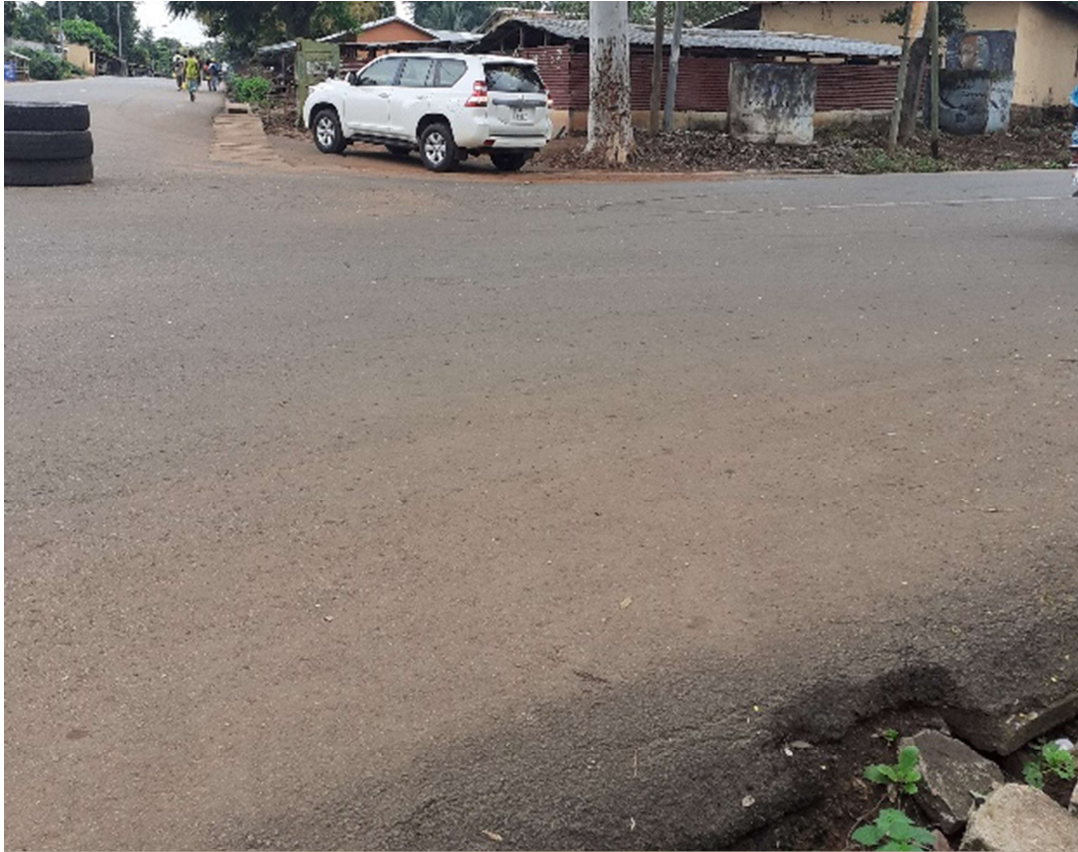
Photo 3 : Deuxième traversée de route bitumée
