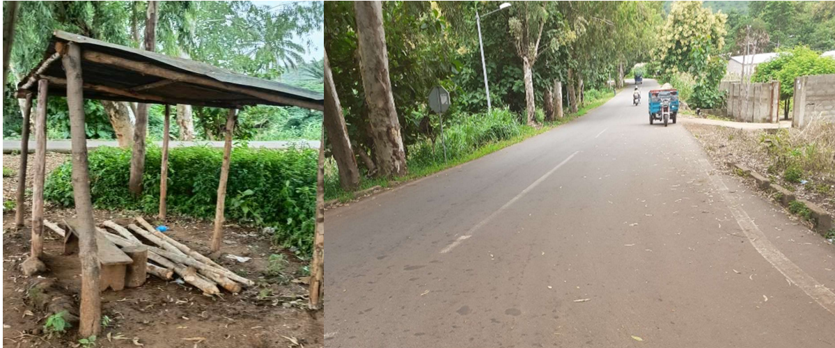
Photo 1 : Hangar à enlever et route bitumée à traverser
