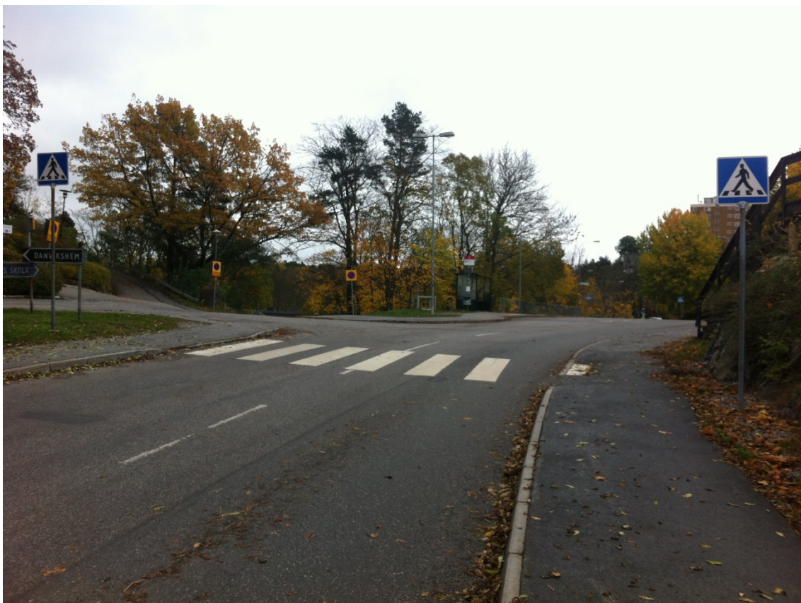
Bild 12 Utmed Danvikshemsvägen passerar eventuell byggtrafik Vilans skolas busshållplats. Trafikanter har delvis skyddad sikt. Foto: Tyréns.
