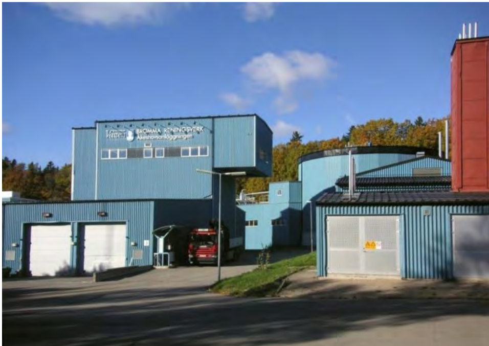
Figur 2.2 Bromma reningsverk, Åkeshovsanläggningen. På bilden syns bland annat slamutlastningen och en av rötkamrarna.
