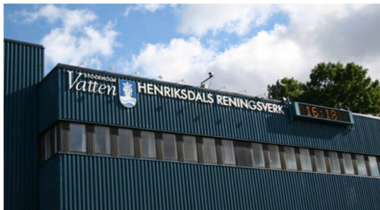
Figur 3.5 Henriksdalsanläggningens kontorsbyggnad (©Stockholm Vatten).
