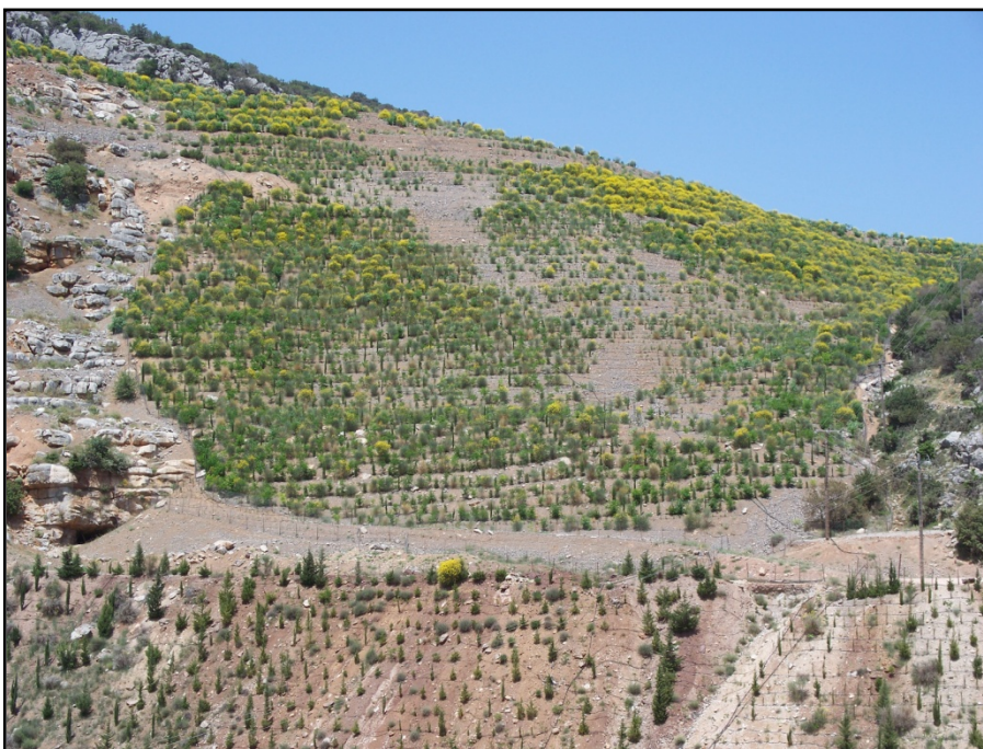
Εικόνα 1.5-2: Εργασίες αποκατάστασης περιβάλλοντος στη θέση Ροδιές
