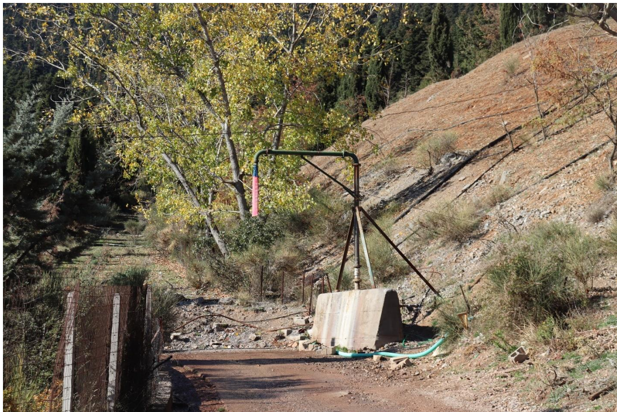
Φωτογραφία 6: Υφιστάμενη αδειοδοτημένη γεώτρηση στις εγκαταστάσεις του 51 ου χλμ Ε.Ο. Λαμίας – Άμφισσας
