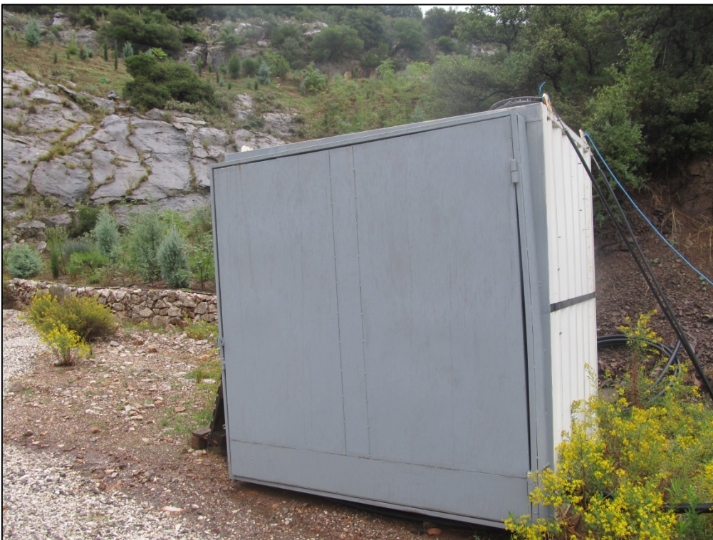
Φωτ. 6: Σύστημα πολυστρωματικών φίλτρων στο χώρο του βοηθητικού συνεργείου
