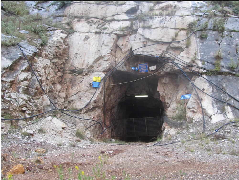
Φωτ. 3: Είσοδος της υπάρχουσας στοάς στην πλατεία Π585
