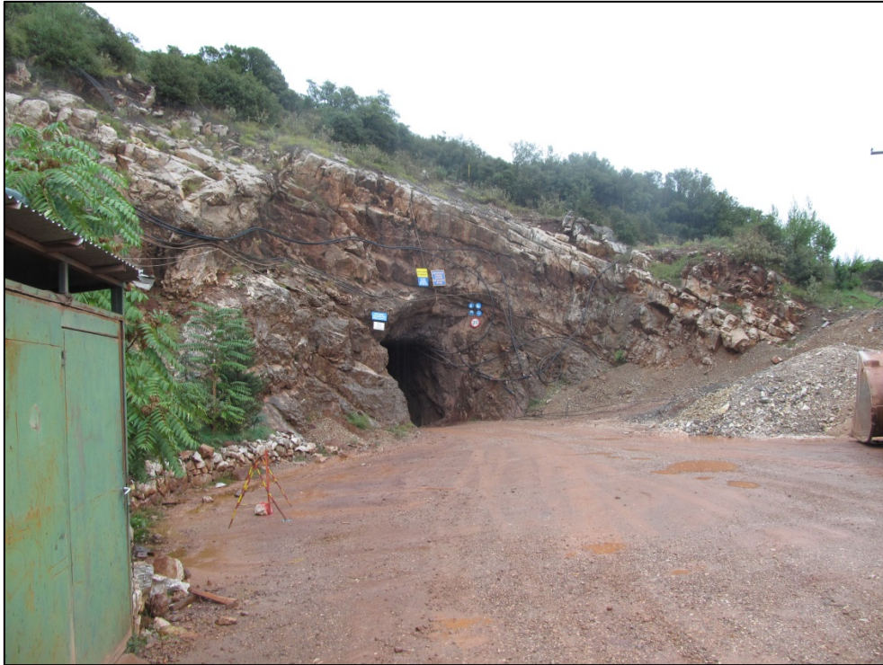
Φωτ. 1: Είσοδος της υπάρχουσας στοάς στην πλατεία Π548
