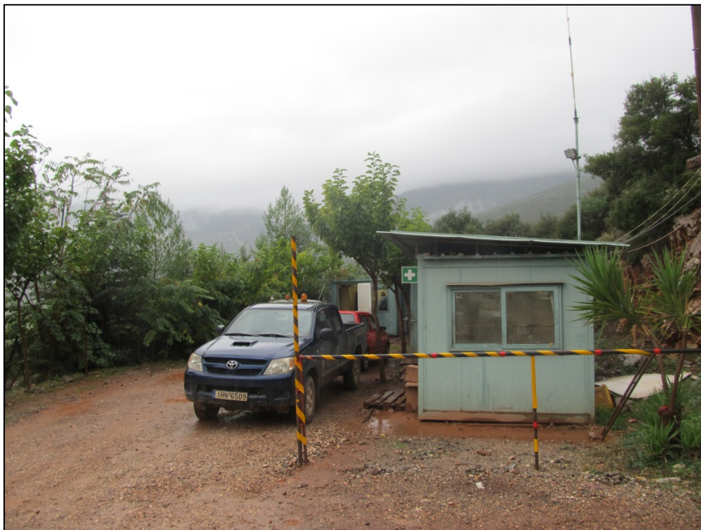
Φωτ. 2: Βοηθητικοί εργοταξιακοί οικίσκοι στην πλατεία Π548
