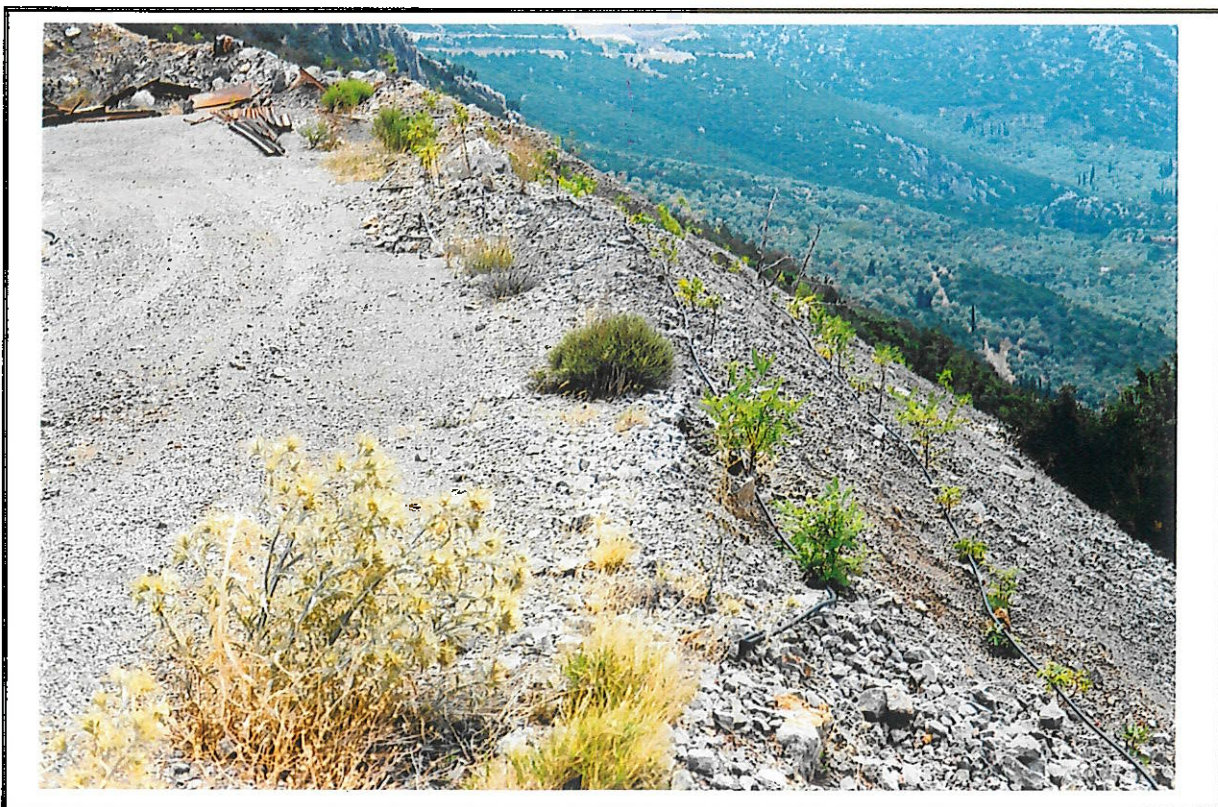
Φωτ.6. Ο χώρος της στοάς Σ630 με φυτεύσεις αποκατάστασης.
