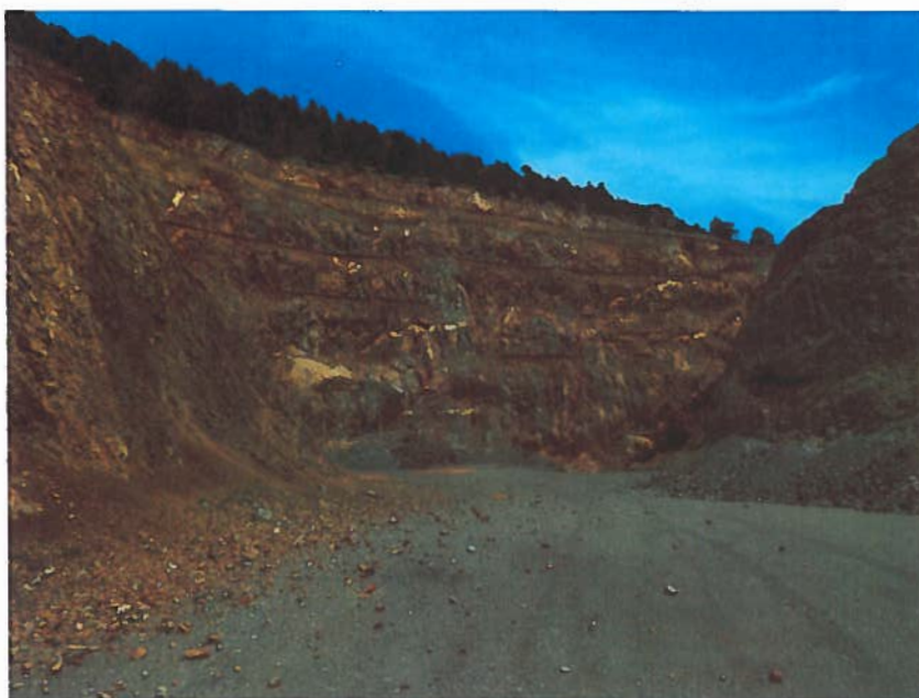
Εικόνα 4.1-1: Υφιστάμενη κατάσταση εξοφλημένης επιφανειακής εκμετάλλευσης Αγία Τριάδα – Δ΄ Φάση
