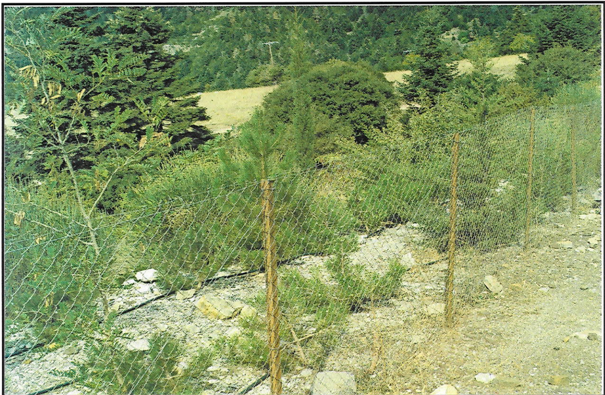
Φωτ.4. Άποψη των φυτεύσεων στο πρανές στείρων μπροστά από την πλατεία Π905. Διακρίνονται επίσης το μόνιμο δίκτυο άρδευσης και η περίφραξη.
