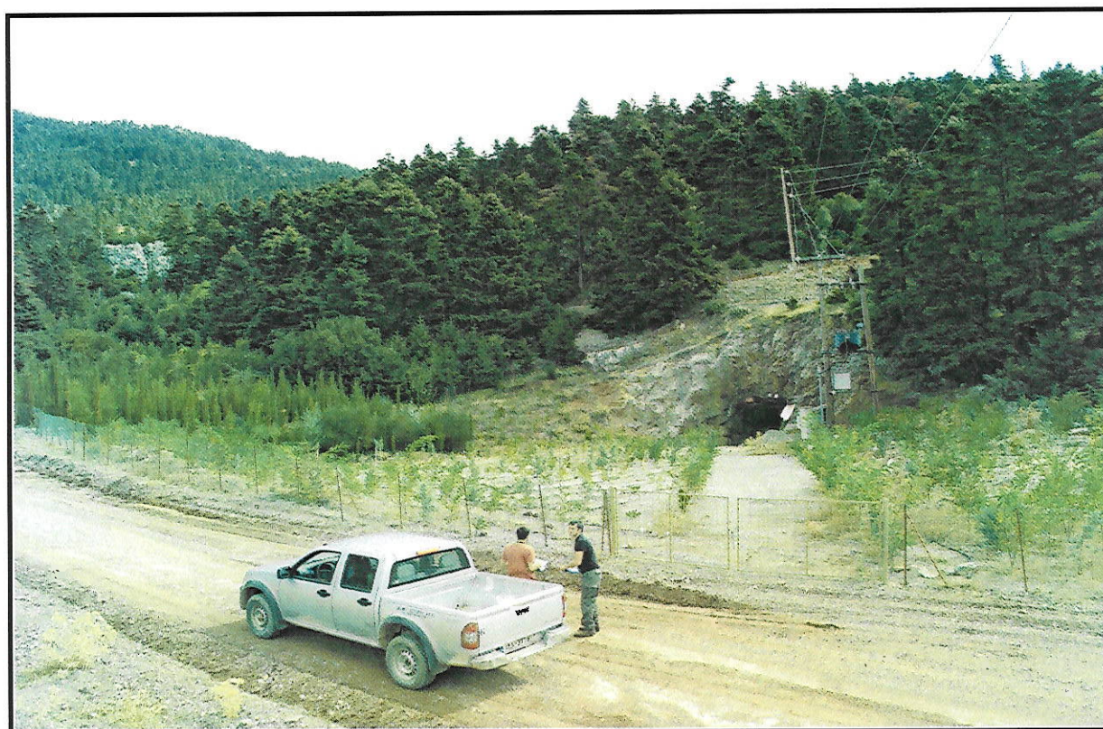
Φωτ.2. Άποψη του χώρου της πλατείας Π956. Διακρίνονται, η είσοδος της στοάς και φυτεύσεις που έχει πραγματοποιήσει η εταιρεία.
