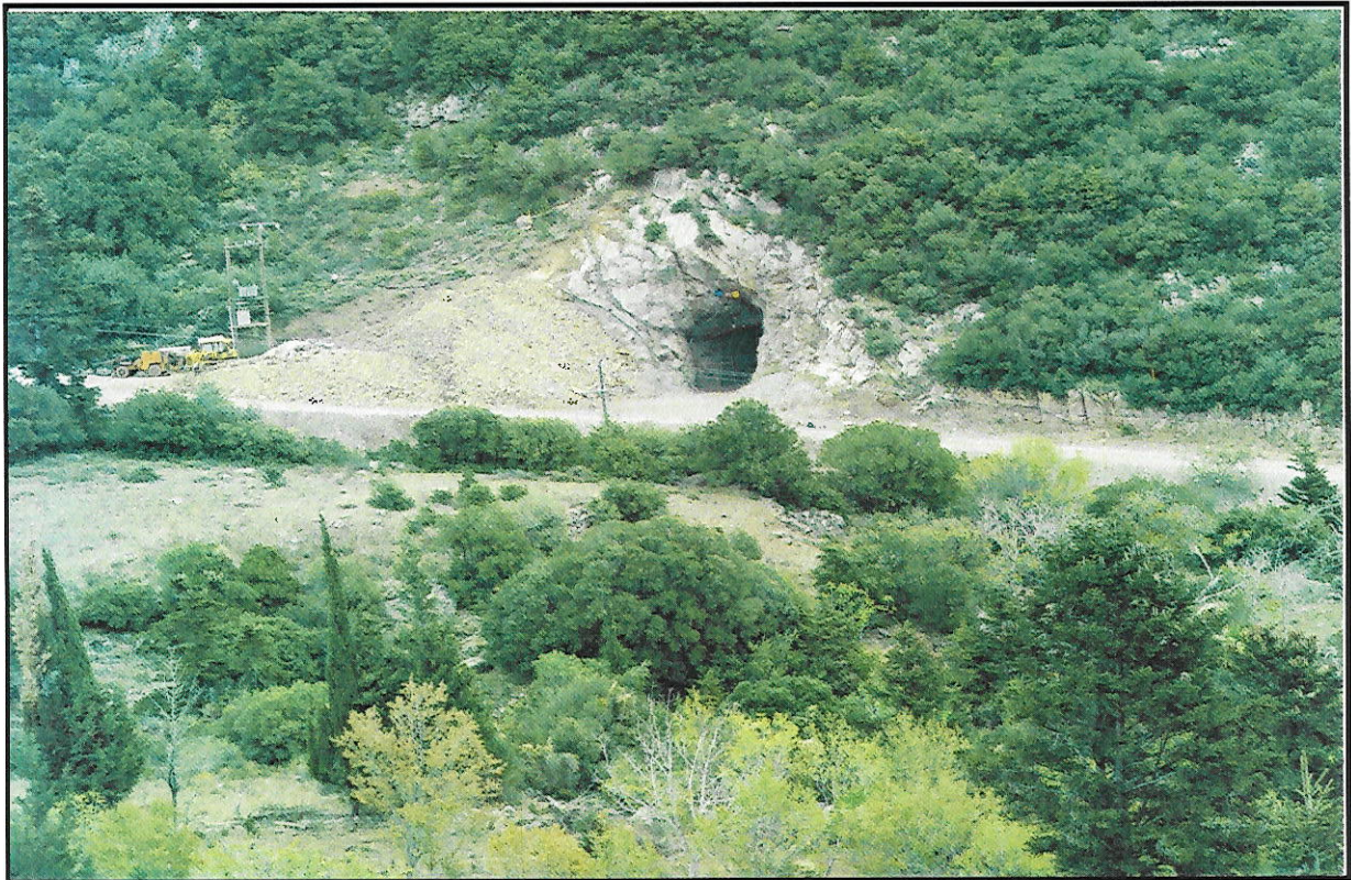
Φωτ.3. Άποψη του χώρου της πλατείας Π808. Διακρίνονται, η είσοδος της στοάς και η φυσική βλάστηση της ευρύτερης περιοχής.
