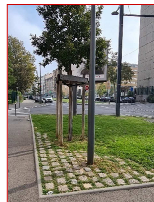
Exemple de joints fertiles (T6S – Moulin à vent)
