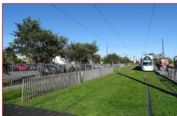
Plate-forme de tramway végétalisée
