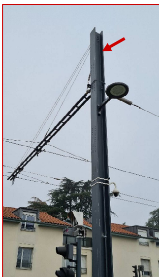
T6 Sud – Poteaux LAC présentant une orientation plus favorable à l'installation d'une éventuelle structure d'accueil pour la petite faune en hauteur.
