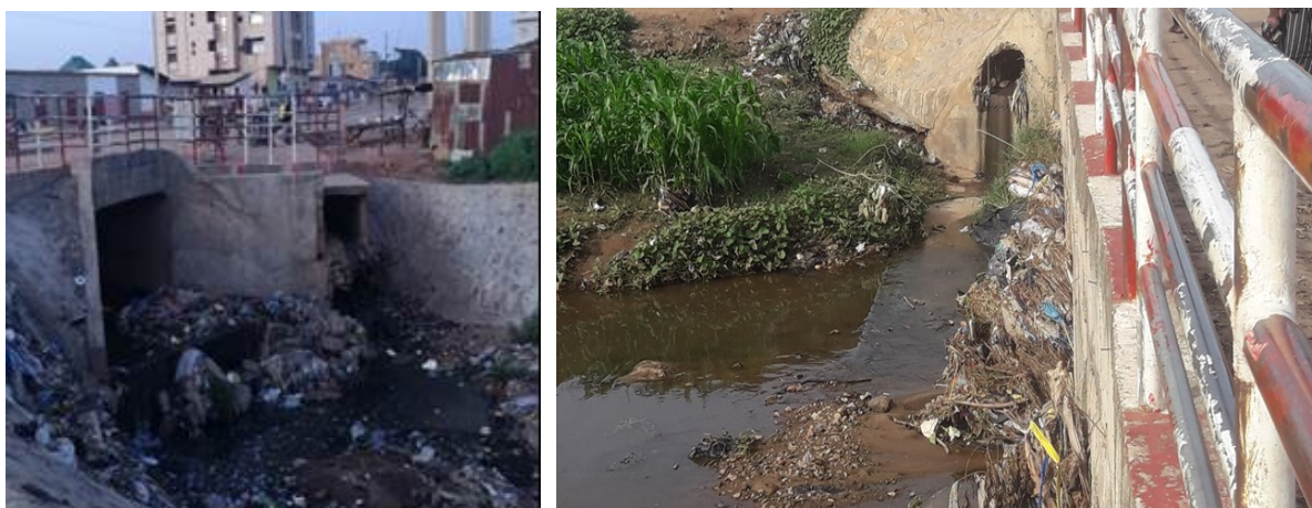
Lit et ouvrage sur un collecteur existant encombré de déchets et de sable
