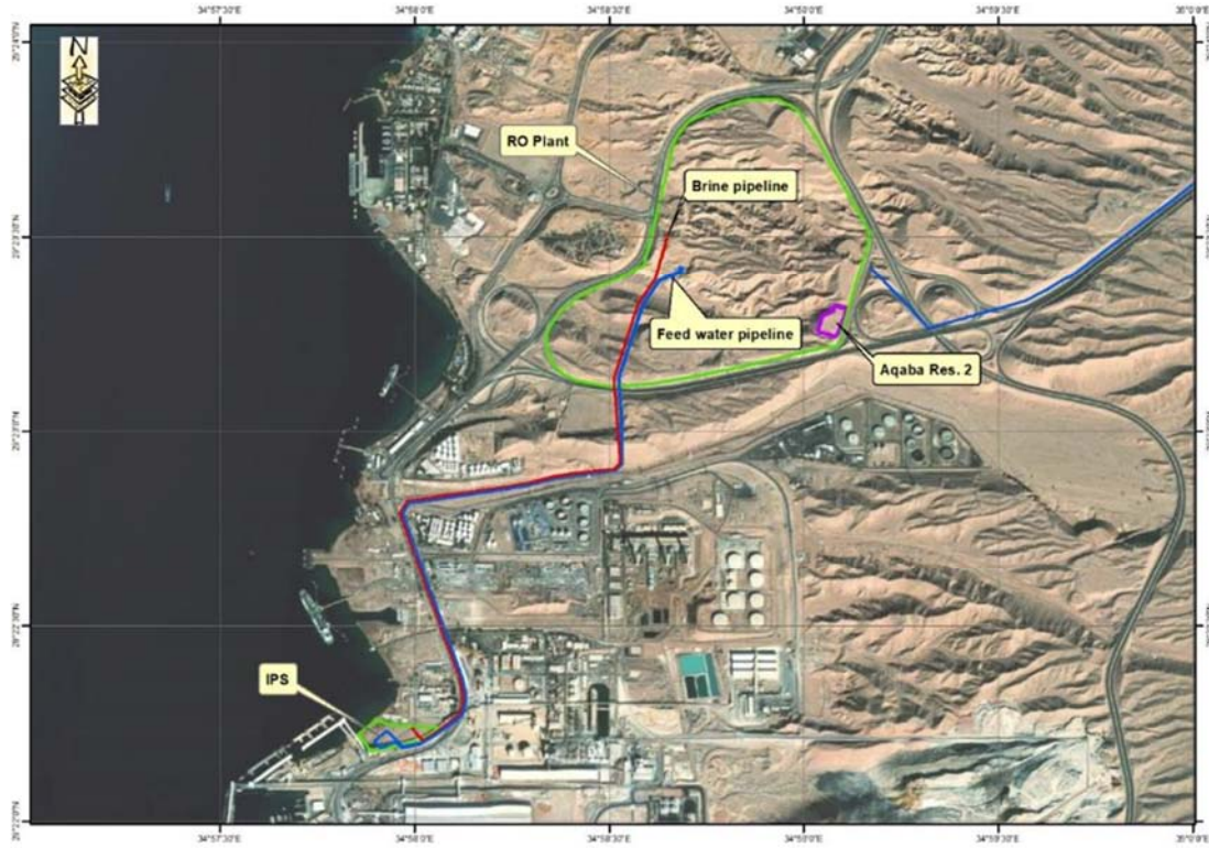
الشكل 3: خزان العقبة 2 في موقع محطة تحلية مياه البحر بالتناضح العكسي SWRO.
