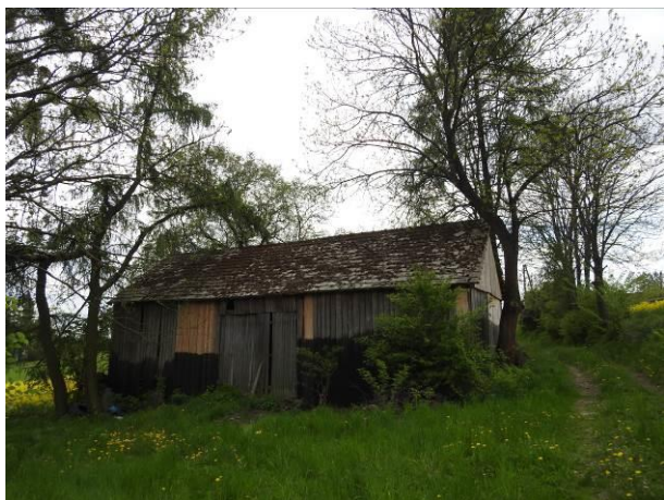
Fot.3. Stodola zlokalizowana w rejonie początku inwestycji
