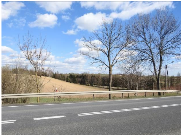
Fot. 1. Początek planowanej inwestycji - miejsce włączenia do DK9
