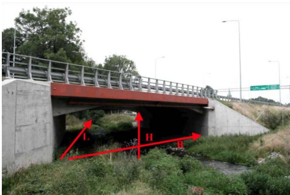
Fotografia 6-1 Przykładowe rozwiązanie przejścia dolnego średniego dla zwierząt
