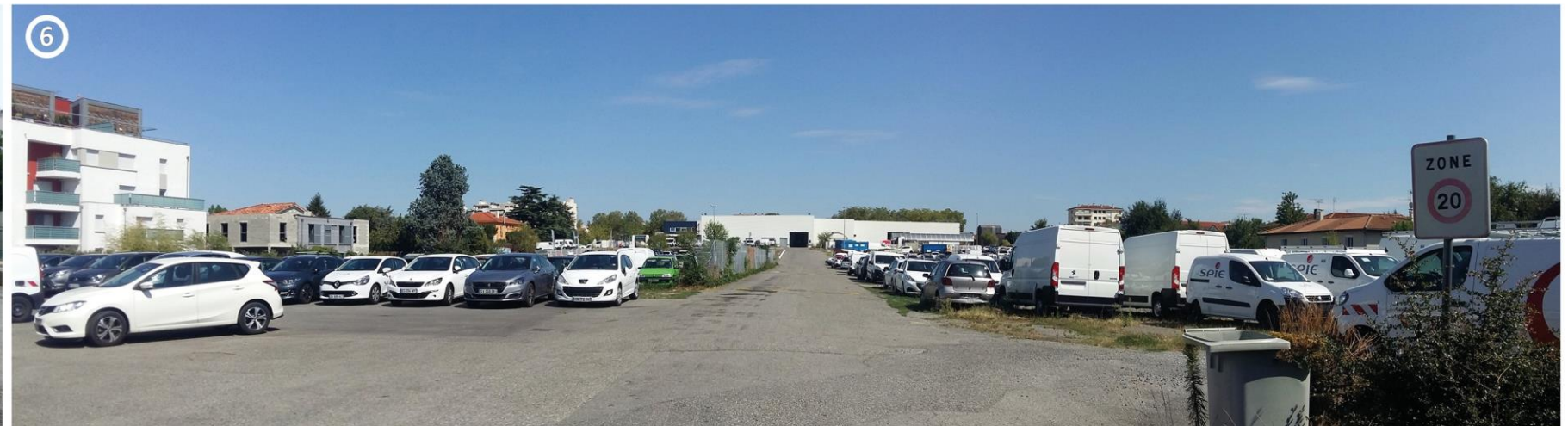
△ Emplacement de la future station 'Fondevre' actuellement occupée par le stationnement du garage Peugeot
