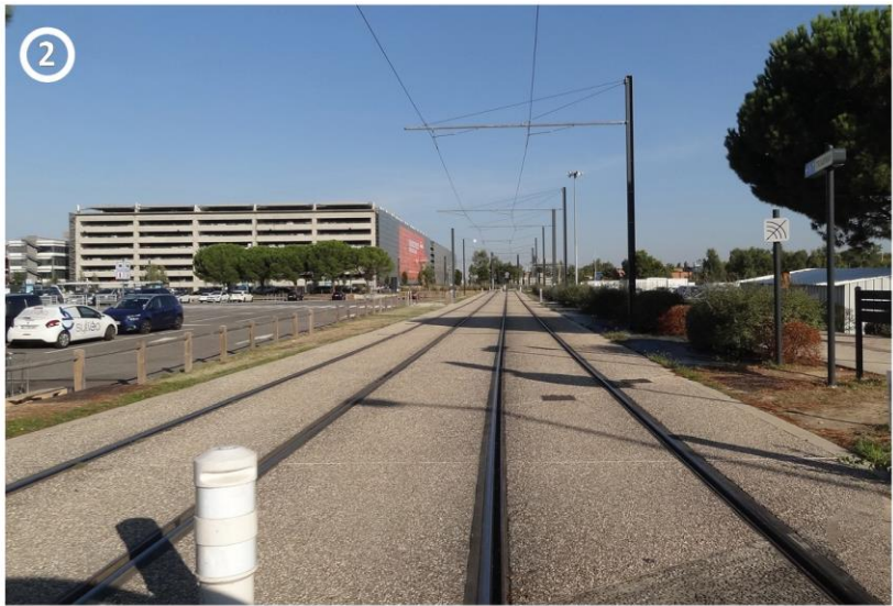
△ A l'approche de l'aéroport, la ligne de tramway s'inscrit dans un contexte fortement minéralisé où le végétal est peu présent.
