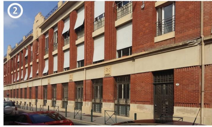
△ Façades art déco de la Poste avec appareillage de briques
