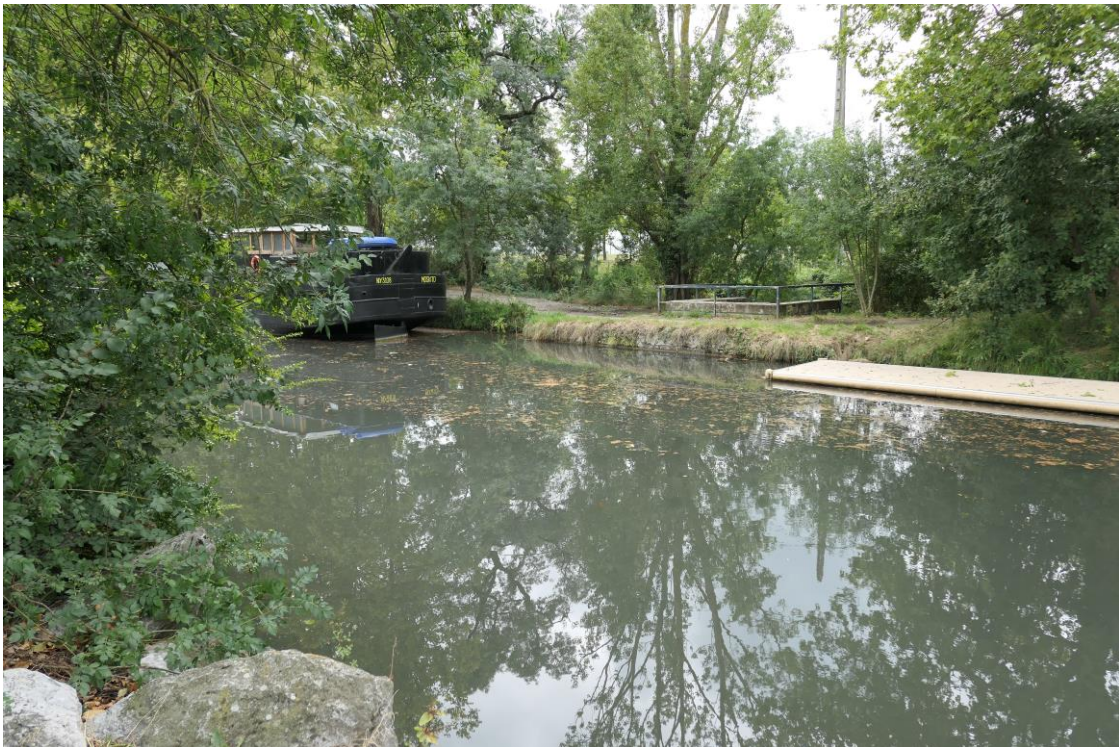
Aqueduc à siphon du ruisseau du Palays (monument inscrit) (source : Egis)
