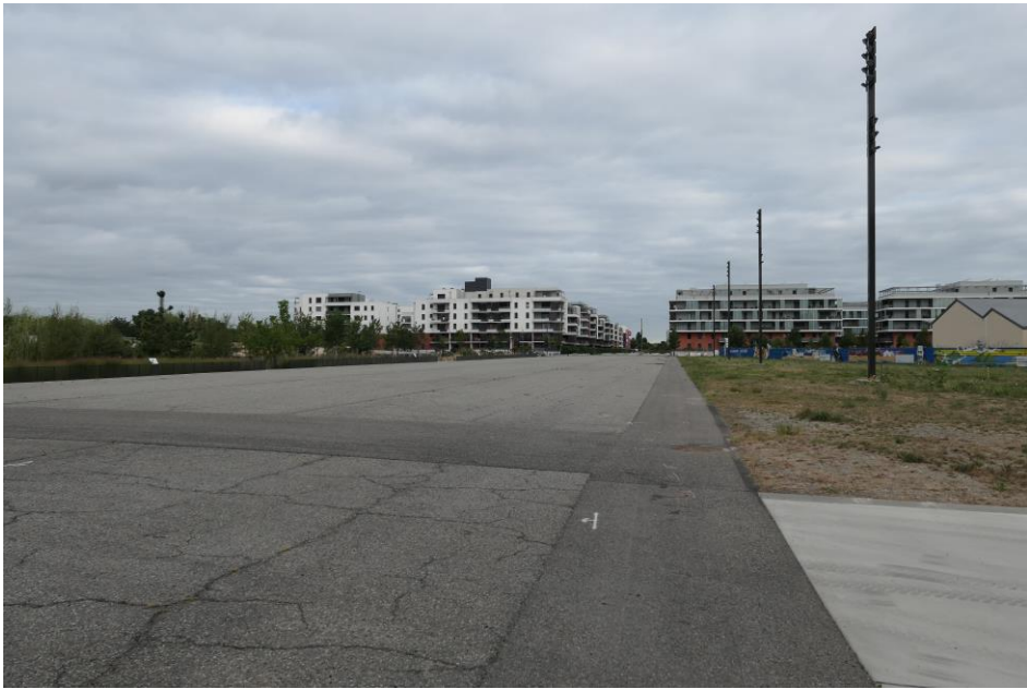
La piste historique de l'aérodrome de Montaudran (source : Egis)
