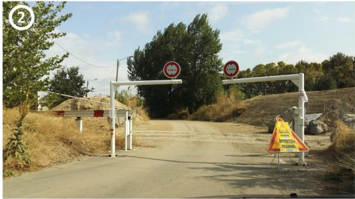
△ Terrain vague et chantier sur l'ancien aérodrome
