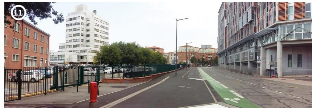
△ Stationnements clôturés à l'emplacement de la future station 'Matabiau-Marengo'
