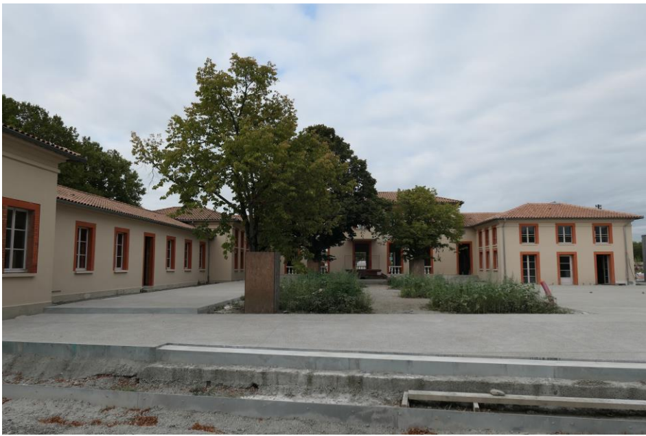
Bâtiment historique réhabilité dans le cadre du projet d'espace mémoire aéro (source : Egis)
