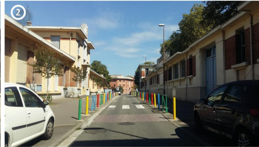
② Façades remarquables en briques de l'école Jules Ferry (élément bâti protégé répertorié au PLUiH)
