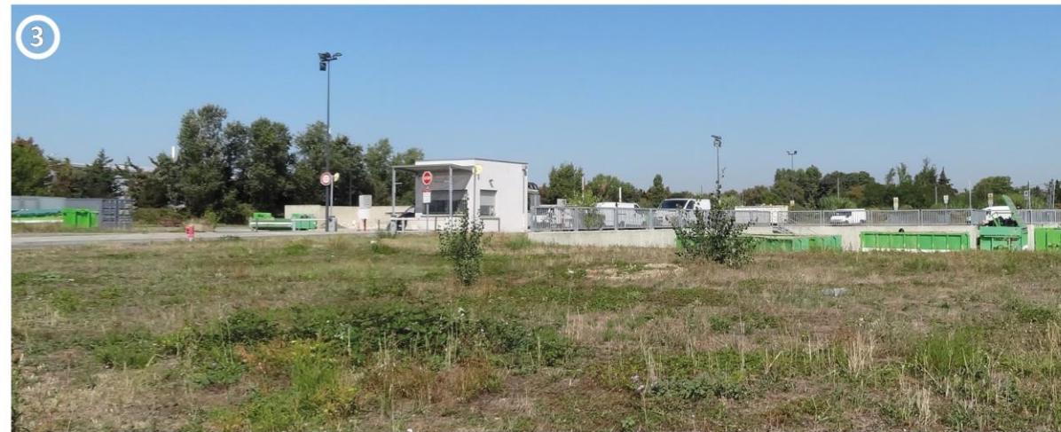
3 L'emplacement du futur site de maintenance et de remisage est actuellement occupé par la déchetterie professionnelle des Daturas.
