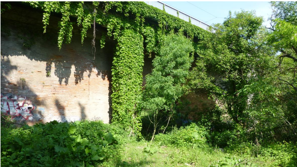
Pont sur le Touch à Saint-Michel du Touch (monument inscrit) (source : Egis)
