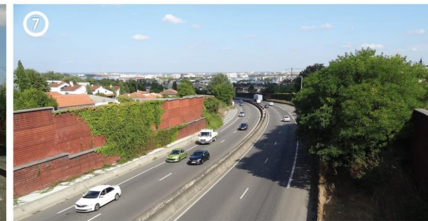
△ La RN124 forme une barrière au cœur du tissu pavillonnaire. Le haut du coteau offre des vues lointaines
