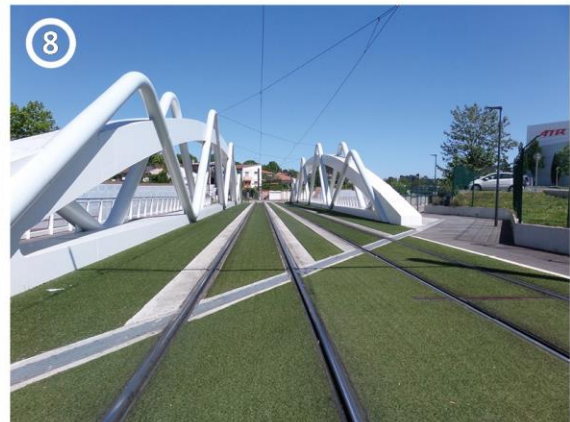
△ Viaduc contemporain du franchissement de l'A621 par le tramway
