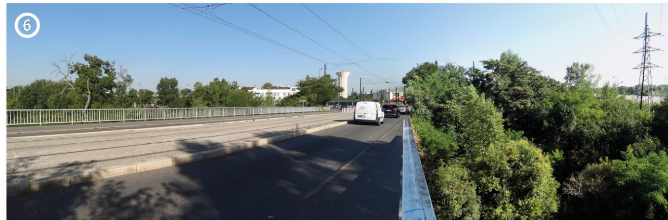
△ Le pont d'Ancely liant Saint-Michel-du-Touch (Toulouse) à Blagnac est monument historique inscrit. Il survole la généreuse ripisylve du Touch
