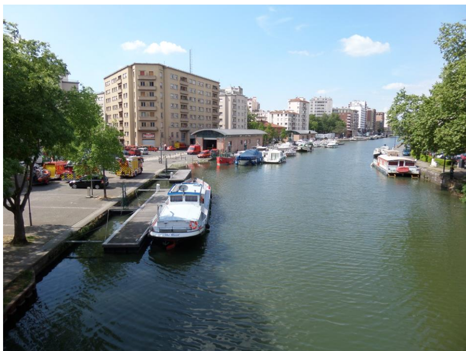
Le Canal du Midi au Port Saint-Sauveur (Source : EGIS)
