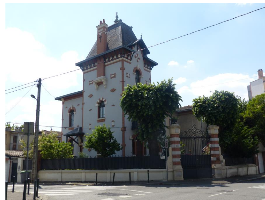
Maison dans l'ensemble urbain protégé Leygue (Source : EGIS)
