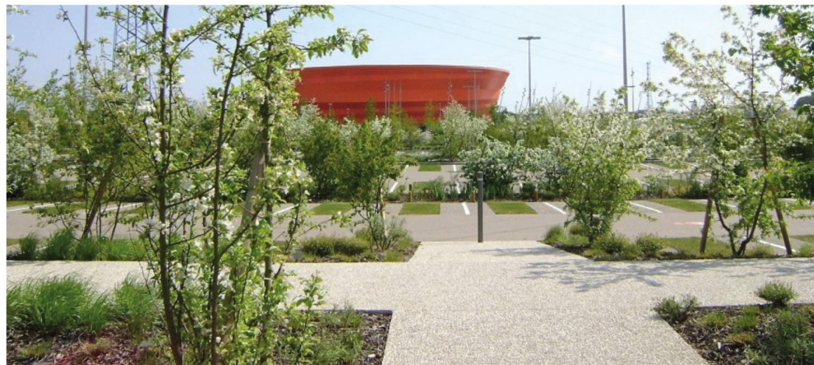
Référence de revêtements de sol perméables sur le parking du Zenith de Strasbourg (Villes et Paysages)
