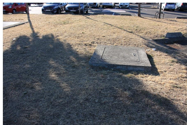
△ Photographie de référence des émergences ◁ d'un ouvrage annexe enterré (Ouvrage technique de la ligne B à proximité de la station La Vache du métro de Toulouse).
