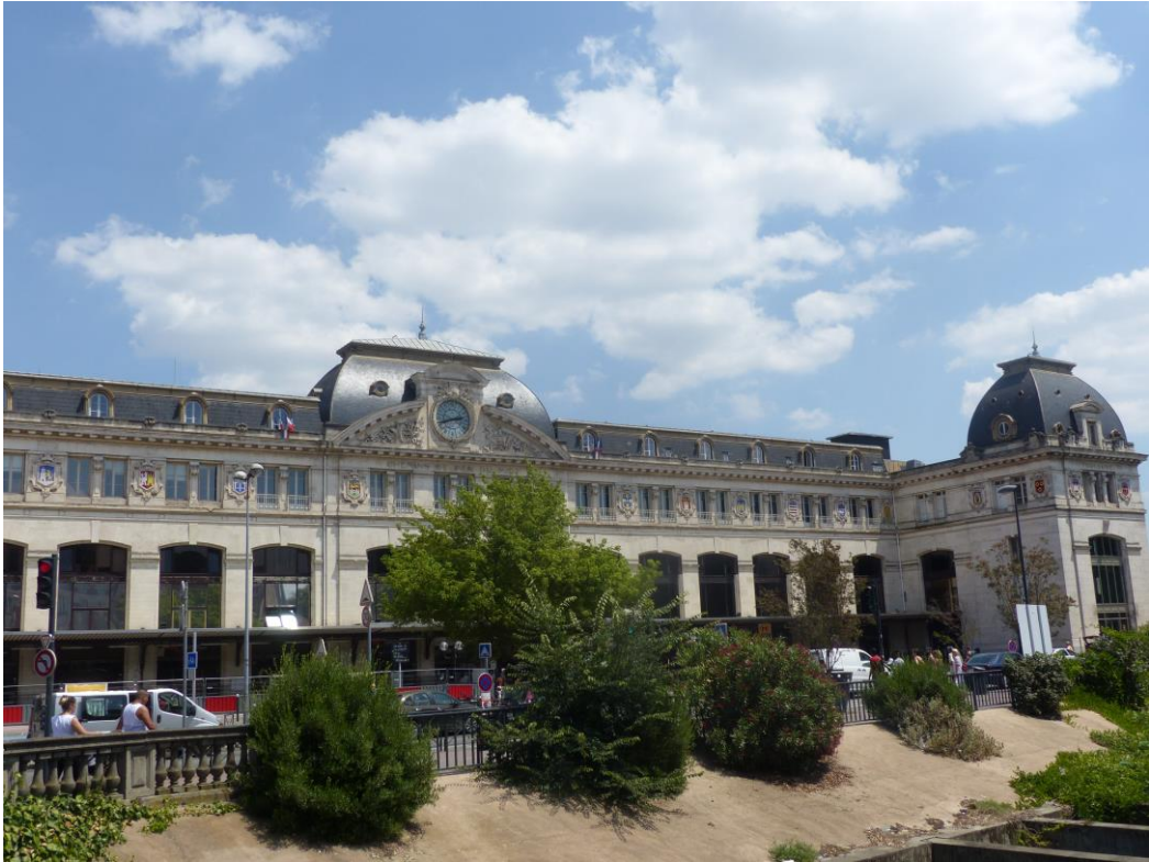
Gare Matabiau (Source : EGIS)
