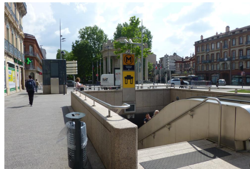
Bouche d'entrée de la station François Verdier existante sur la ligne B (Source : EGIS)
