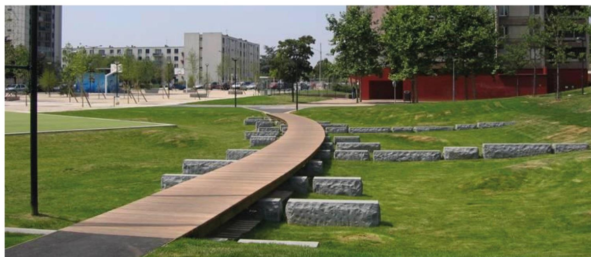
Exemple de traitement paysager d'un bassin d'orage en milieu urbain au parc de la Saussaie (Composante Urbaine)
