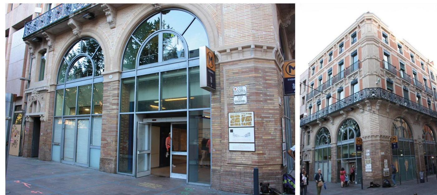
△ Le contexte urbain a imposé la réalisation de station à l'intérieur de bâtiments existants émergents en centre-ville. La station Esquirol s'intègre ainsi dans le contexte architectural de la place du même nom, proposant ainsi un accueil et un service billettique de niveau avec l'espace urbain. Le vocabulaire des émergences de métro se limite aux enseignes drapeau à l'angle des deux rues.
