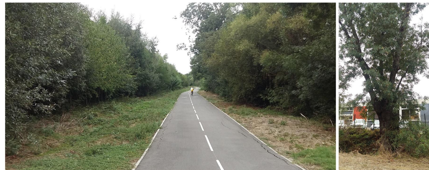
△ Le long du site de l'AFPA, la véloroute bénéficie d'un cadre verdoyant, insérée dans un épais cordon boisé, faisant oublier la proximité du nœud autoroutier. Certains arbres, installés à proximité du ruisseau, sont remarquables.
