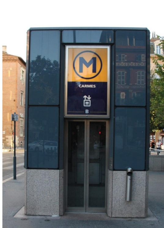
△ La présence de la station sur le sol de l'espace public est minimal, avec une bordure périphérique de 20cm en granit rose. Le matériau de sol est conservé en fonction de son contexte local et urbain.
