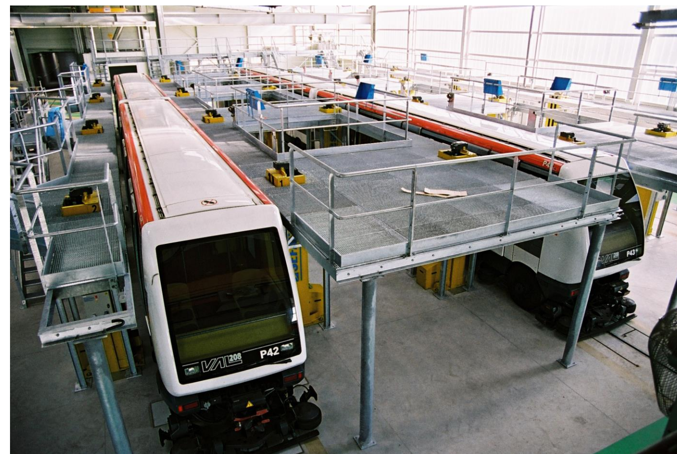
Photographie du garage atelier de la ligne B à Borderouge
