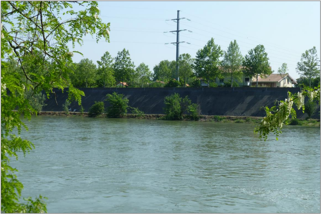
La digue des Sept Deniers en rive droite de la Garonne
