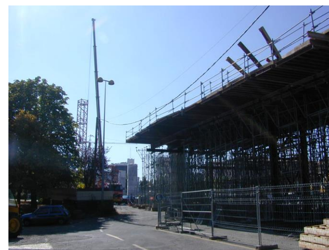
Photo métro ligne A, construction du viaduc de Jolimont
