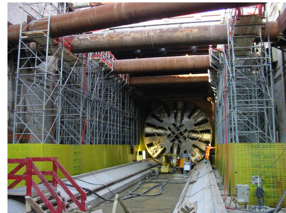
Photo métro ligne B, entrée du tunnelier en station © Tisséo Ingénierie
