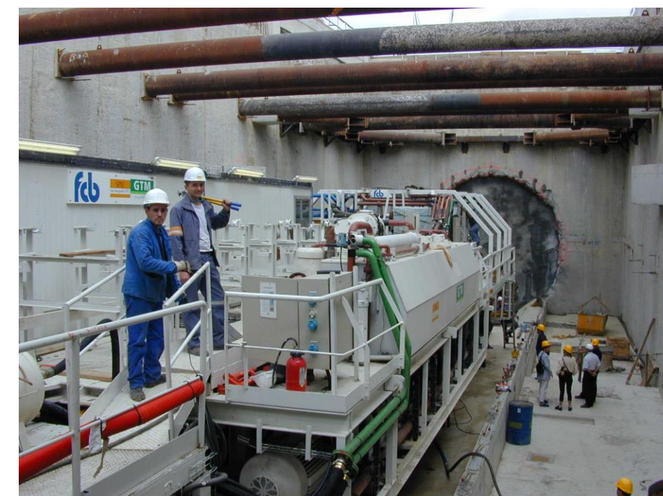
Photo métro ligne B, tunnelier en station (Université Paul Sabatier) © Tisséo Ingénierie
