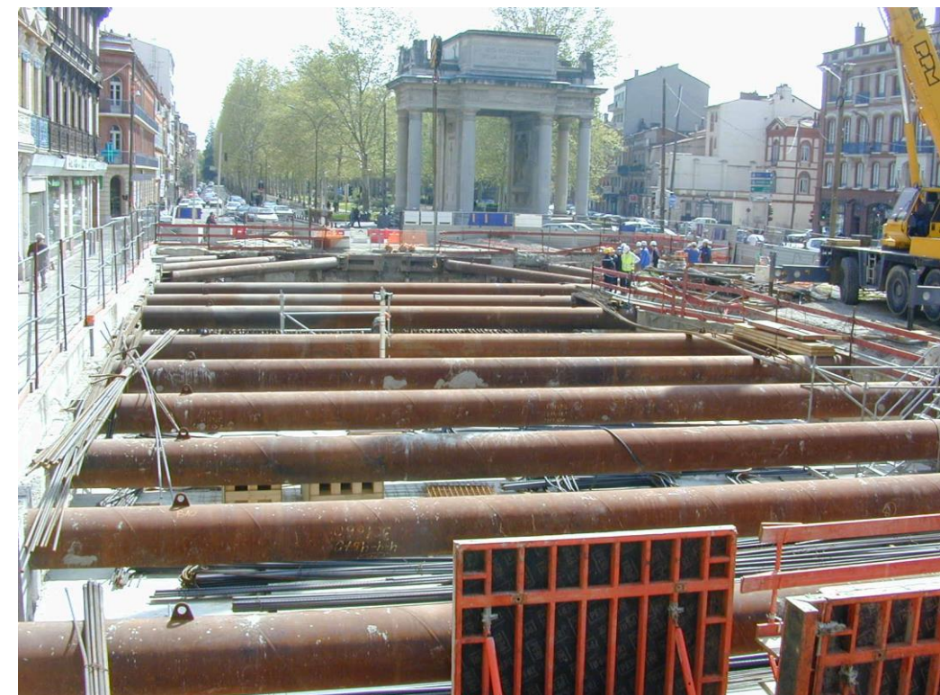
Photo métro ligne B, construction de la station François Verdier © Tisséo Ingénierie
