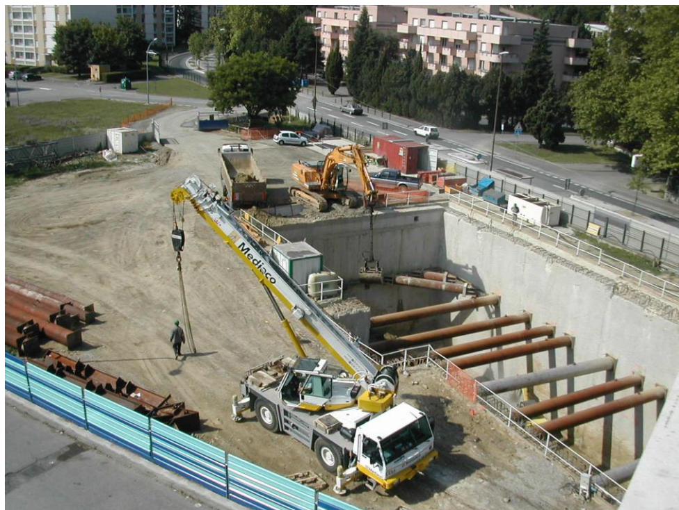
Photo métro ligne B, construction d'une station en parois moulées à ciel ouvert. © Tisséo Ingénierie
