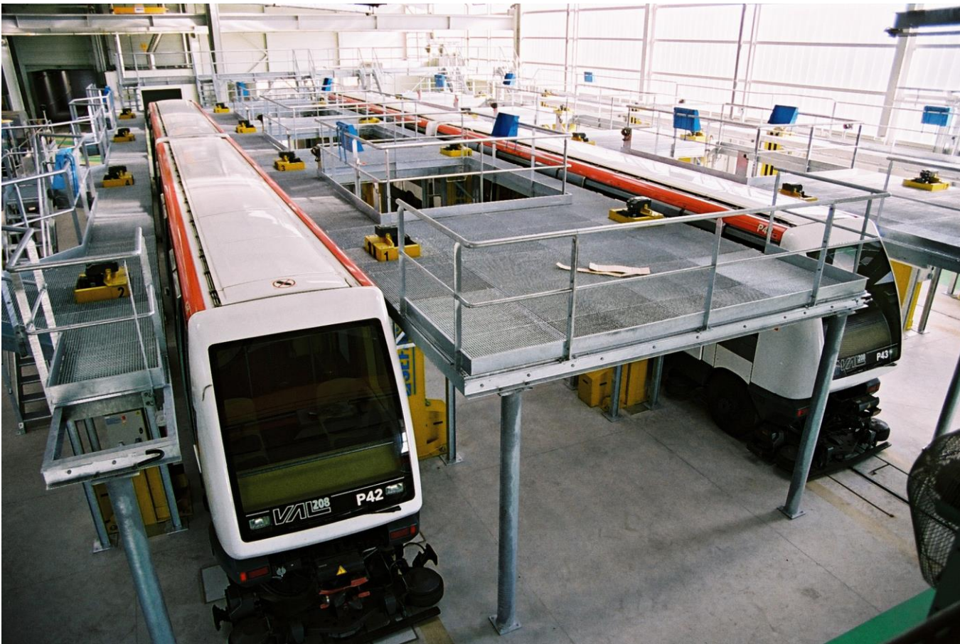
MéTRO ligne B, site de maintenance et de remisage de Borderouge, © Tisséo Ingénierie
