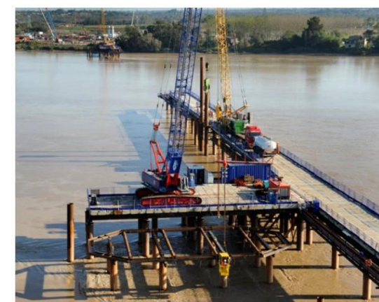
Exemple de solution estacade – Arcadis
