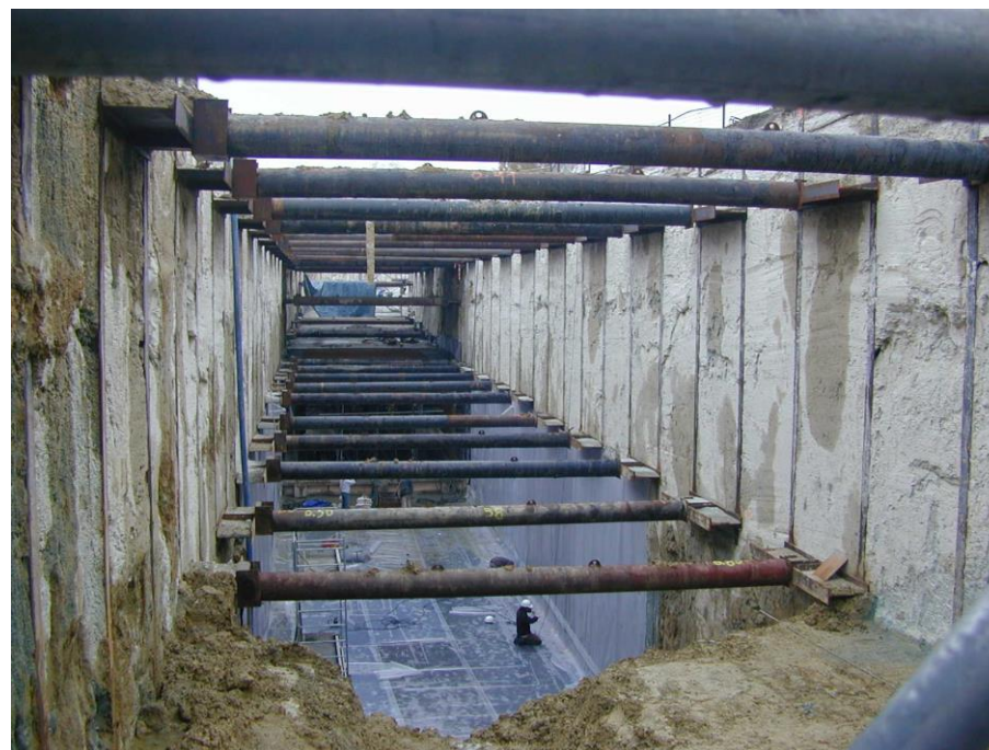
Photos métro lignes A et B, construction de tranchée couverte en parois moulées. © Tisséo Ingénierie
