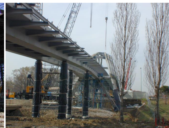
Photo métro ligne A, construction du viaduc sur l'Hers
