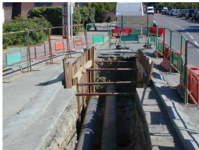
Travaux de déviation de réseaux
