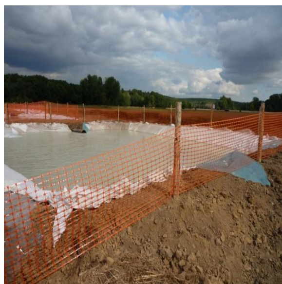
Exemple de bassin d'assainissement provisoire
