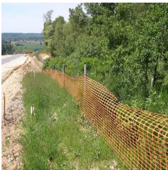
Exemple de barrière de chantier en limite d'emprise travaux
