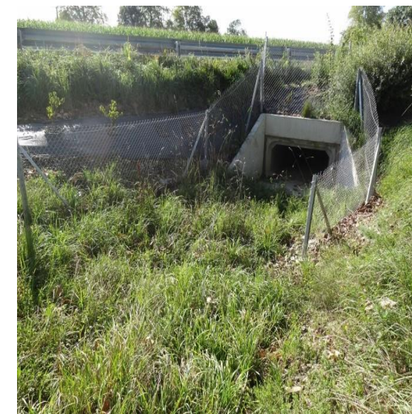
Exemple d'ouvrage de transparence petite faune, inséré sous une voie au niveau du TN
