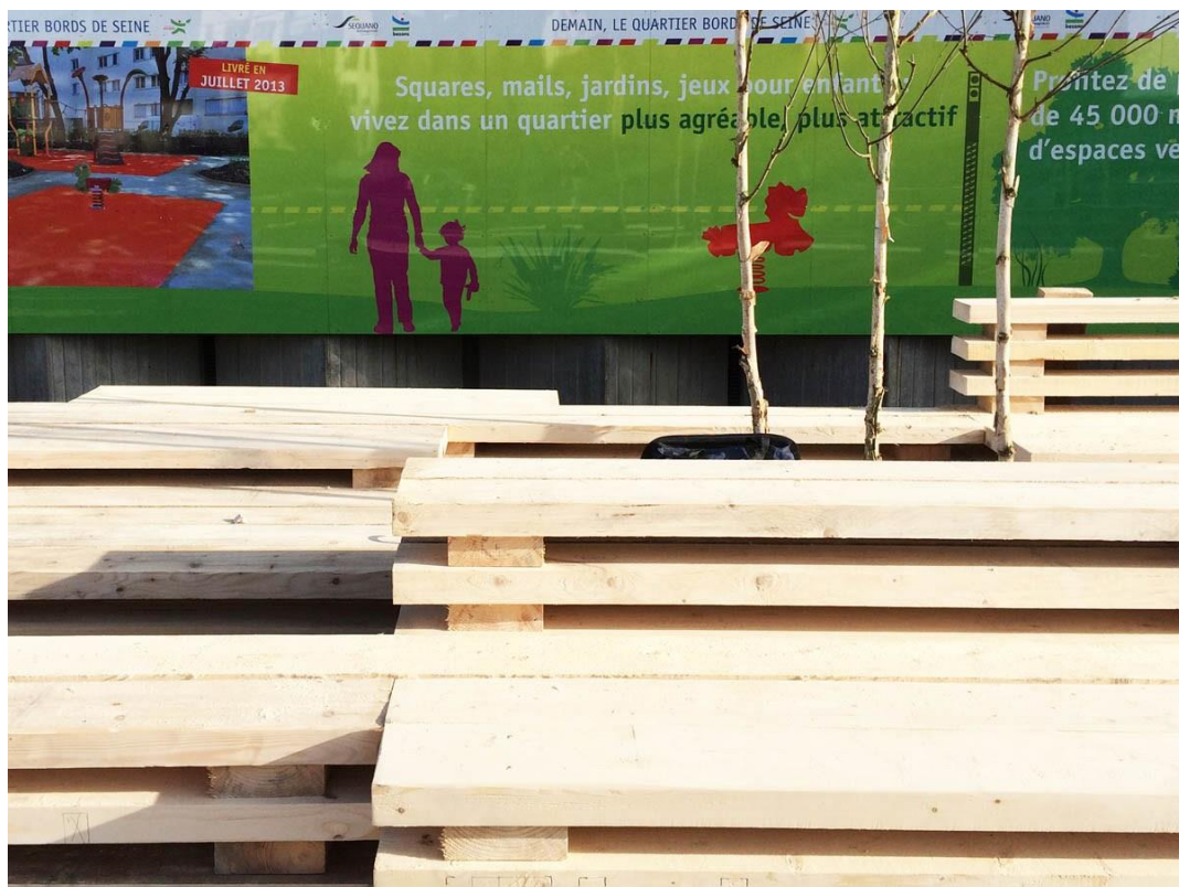
Figure 11: 'Banc-paysage', un exemple d'installation de mobilier éphémère d'accompagnement de chantier urbain (source : Gilles Brusset, Atelier EEM dans le cadre de la ZAC Bords de Seine, Bezons)
