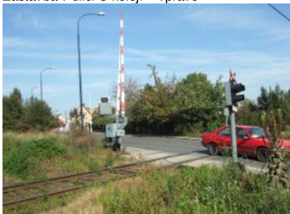
Železniční přejezd na ul. Litovecké
