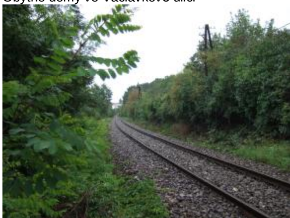
stávající trať za ulicí Gymnazijní
