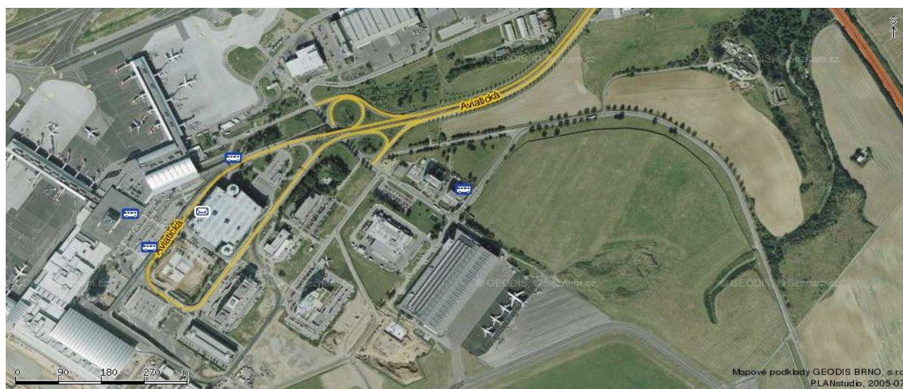
Obr.16 Letiště Praha Ruzyně
