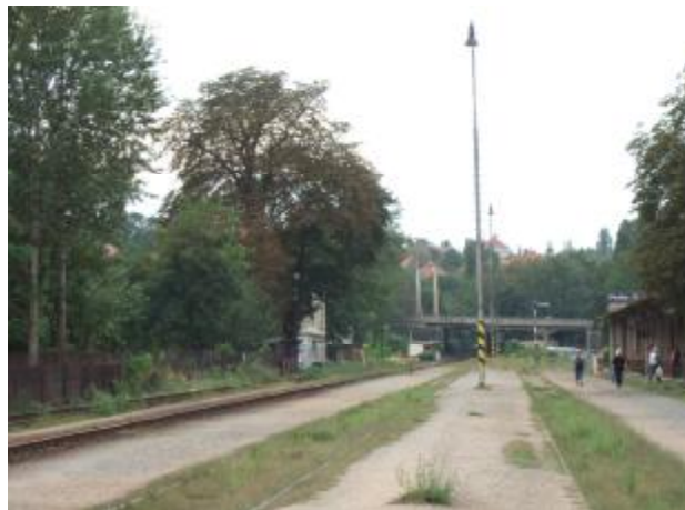
Nádraží Dejvice směr Ořechovka s přemostěním Svatovítské ulice
