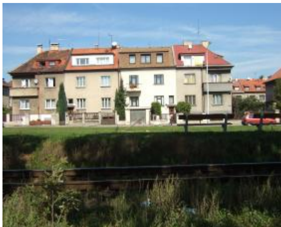
Zástavba v ulici U kolejí - vpravo
