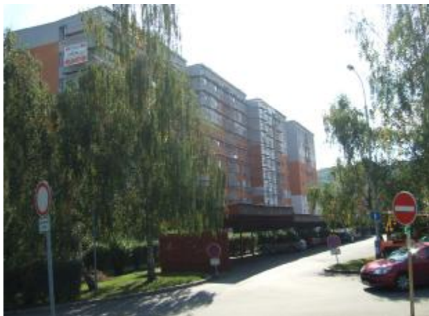
Panelové domy v ulici Brodecké
