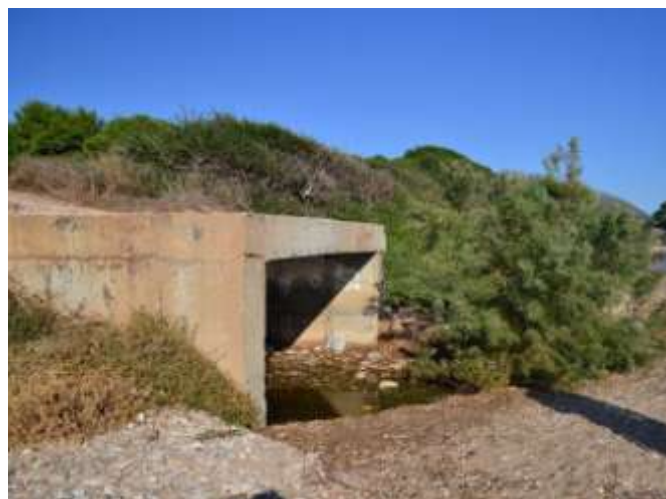
Μ1.Απόληξη του κατασκευασμένου τμήματος Συλλεκτήρα Ζ, Χ.Θ. 0+000
