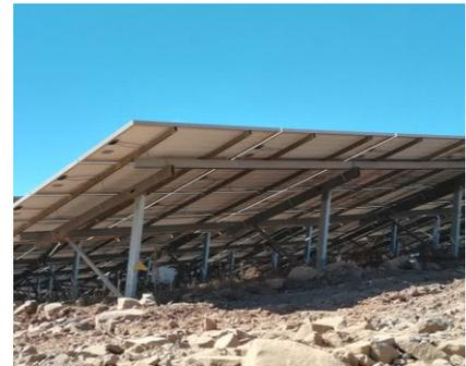
Fotografia 3: Exemplo de estrutura metálica das mesas
