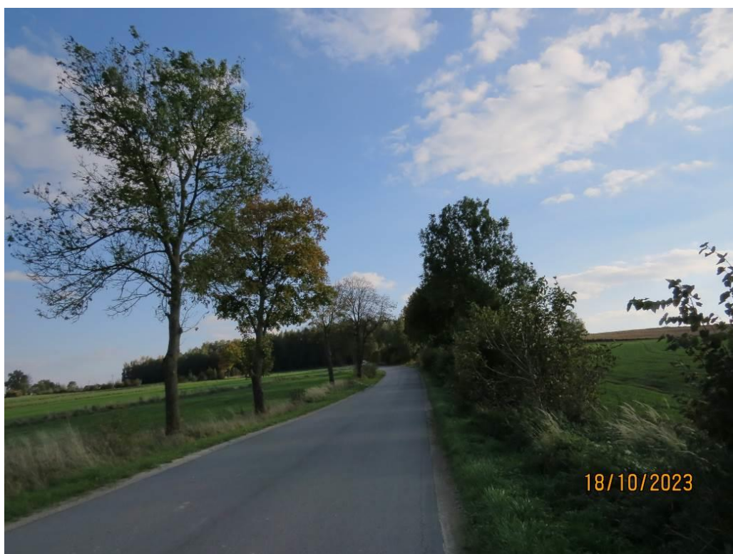
Fotografia 8 Droga powiatowa nr 1545T w rejonie km ok. 8+800 – miejsce projektowanego Węzła Baćkowice
