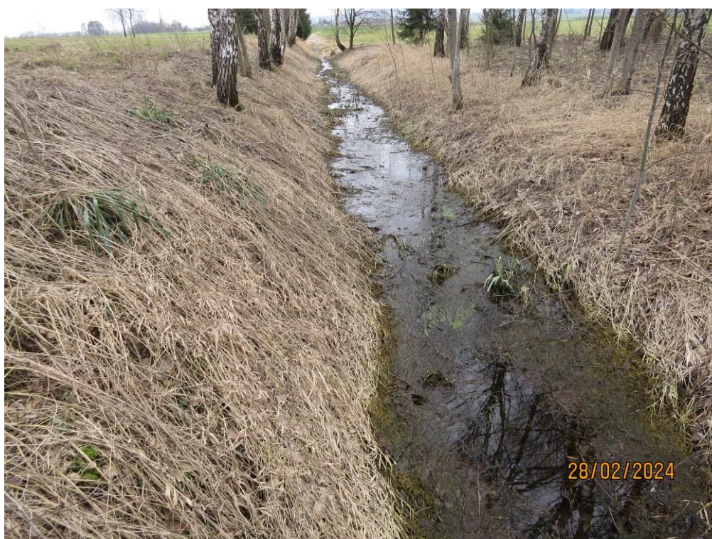
Fotografia 4 Rów melioracyjny R-2 w rejonie km 3+450 str. prawa
