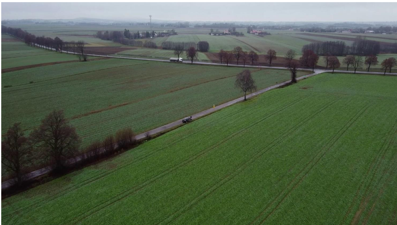
Fot. 2 Widok na skrzyżowanie drogi krajowej nr 74 z drogą gminną w km 3+400 (źródło: opracowanie własne)
