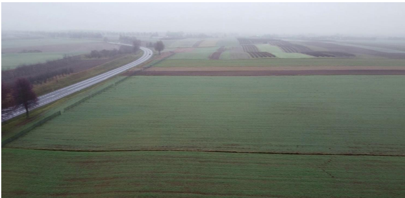
Fot. 12 Koniec projektowanego odcinka drogi S74 w km 9+500 (źródło: opracowanie własne)
