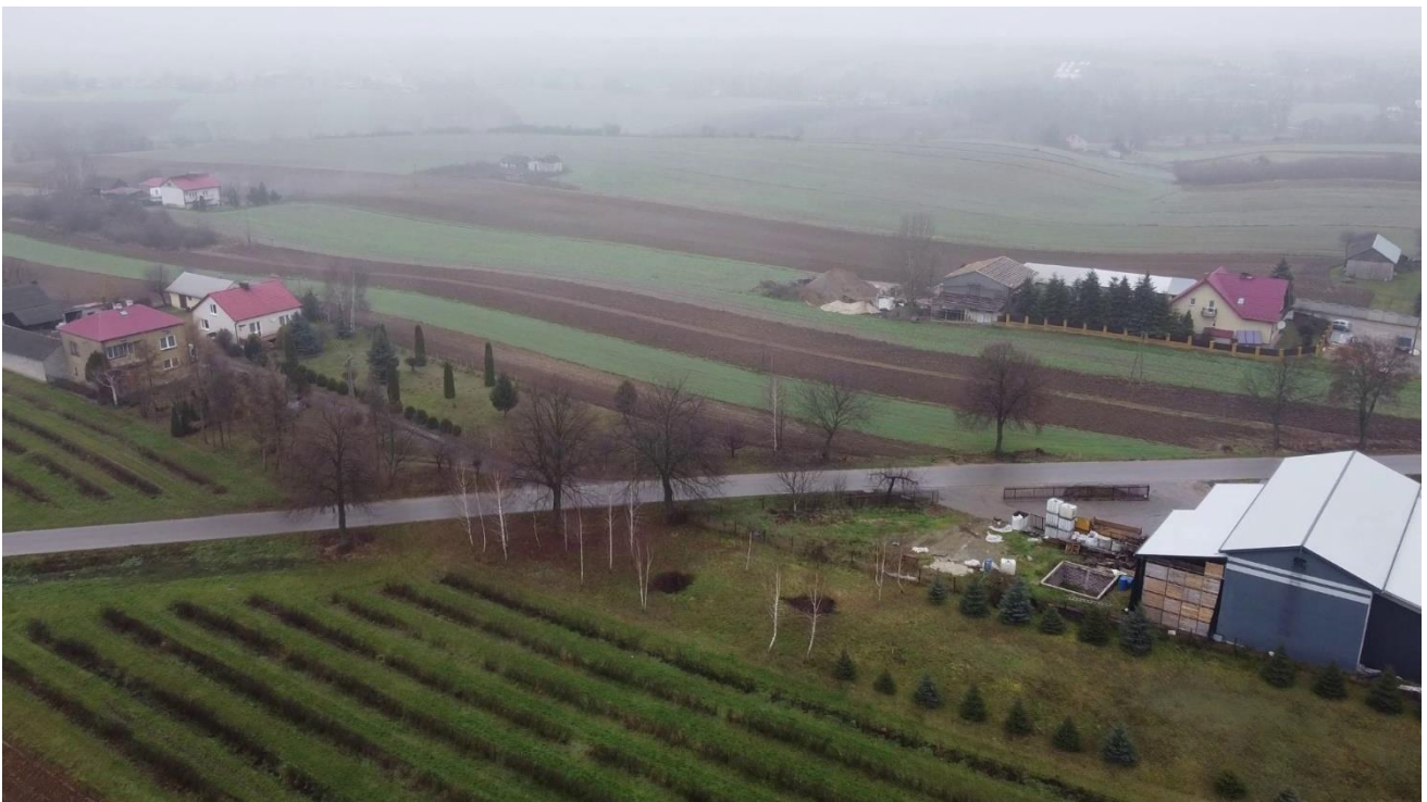
Fot. 21 Przecięcie projektowanej DK9 z drogą gminną oraz zabudowania w liniach rozgraniczających inwestycję w km 3+000 (źródło: opracowanie własne)
