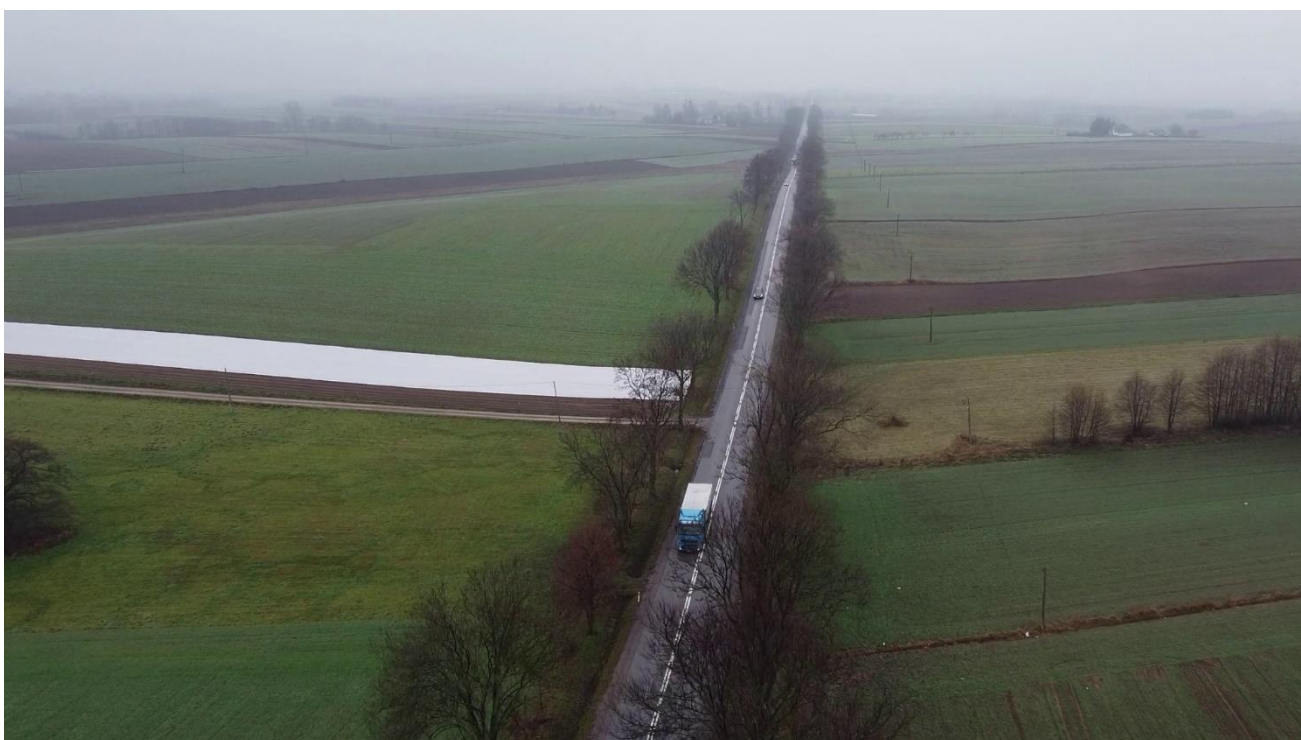
Fot. 25 Zagospodarowanie terenu w miejscu włączenia DK9 do istniejącej drogi wojewódzkiej nr 757 w km 4+900 (źródło: opracowanie własne)
