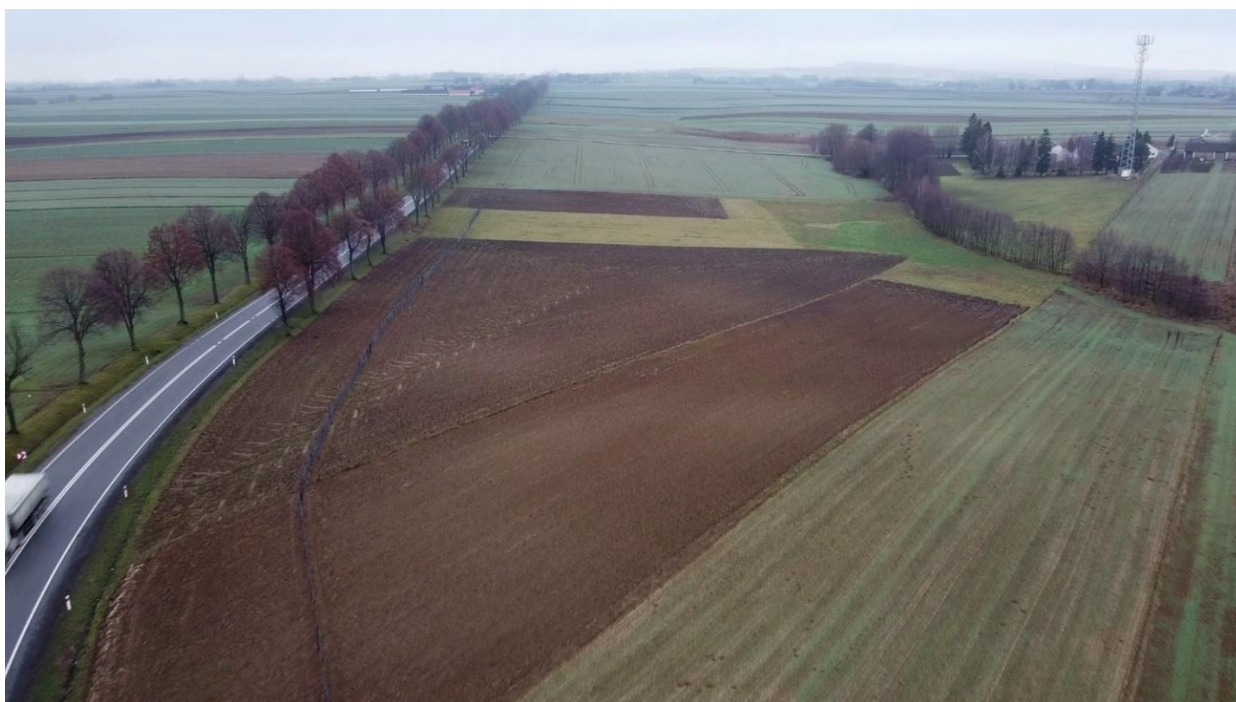
Fot. 1 Początek opracowania - km 3+000 S74 (źródło: opracowanie własne)
