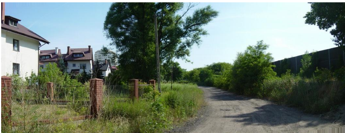
Zdjęcie 5.6.16. Przykład ekranu typu „Zielona ściana” o wysokości 4 m na nasypie wysokości ok. 2m - Krajobraz osadnictwa podmiejskiego i wiejskiego
