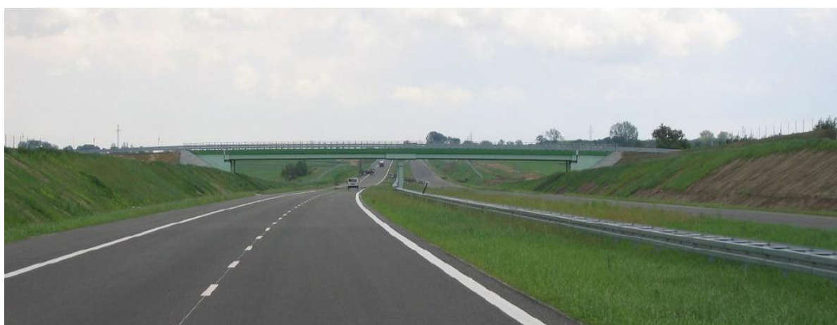
Zdjęcie 5.6.6. Droga poprowadzona w wykopie jest niewidoczna z terenów sąsiadujących z nią. Takie rozwiązanie pozwala też znacznie obniżyć nasypy dojazdu do przejazdu nad drogą.
