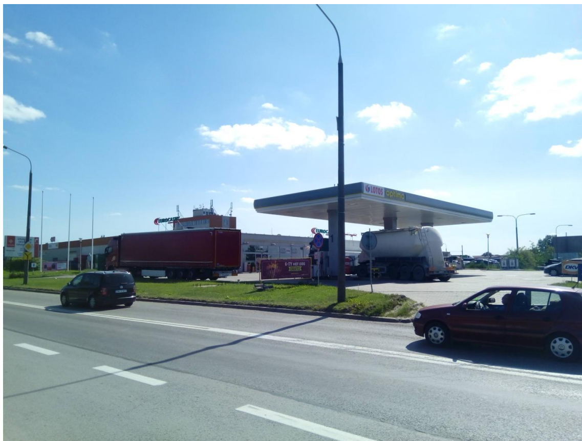
Fot. 1 Stacja paliw LOTOS przewidziana do rozbiórki [fot.: wykonawca Raportu, sierpień 2018]
