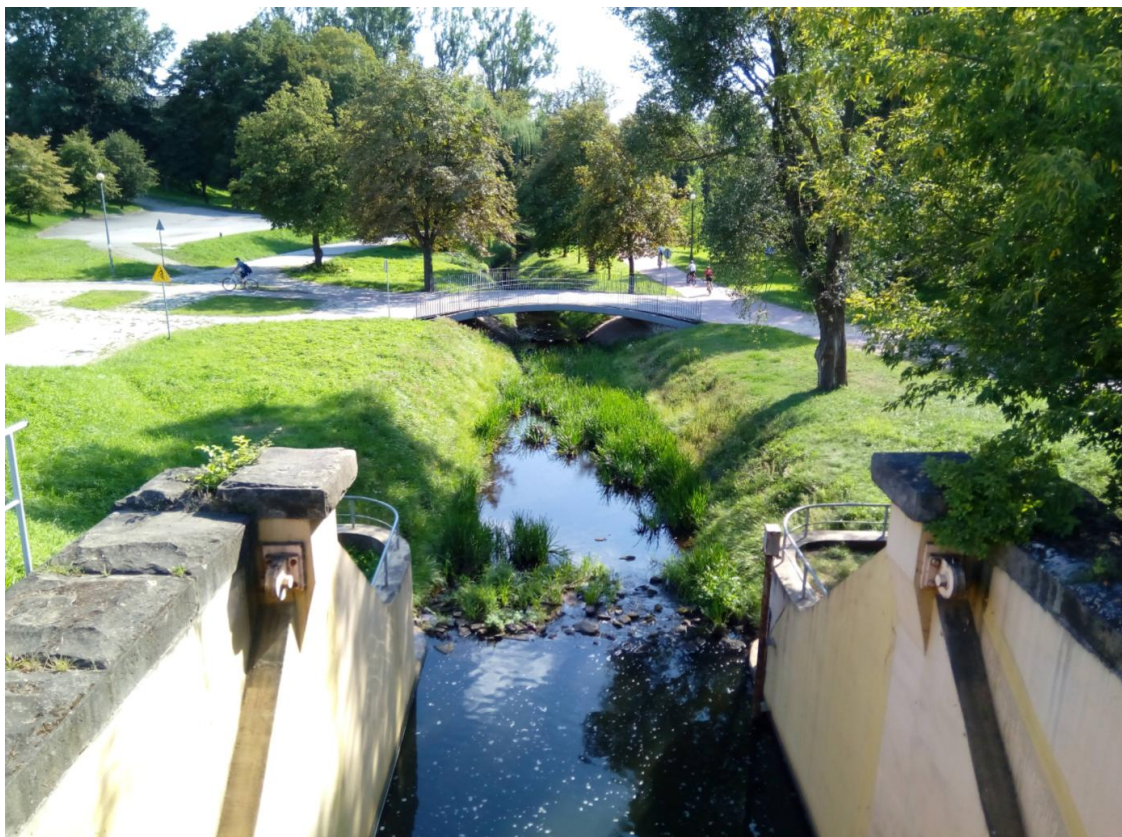
Fot. 2 Widok z urządzenia piętrzącego OH-1 w kierunku rzeki Silnicy [fot.: wykonawca Raportu, sierpień 2018]
