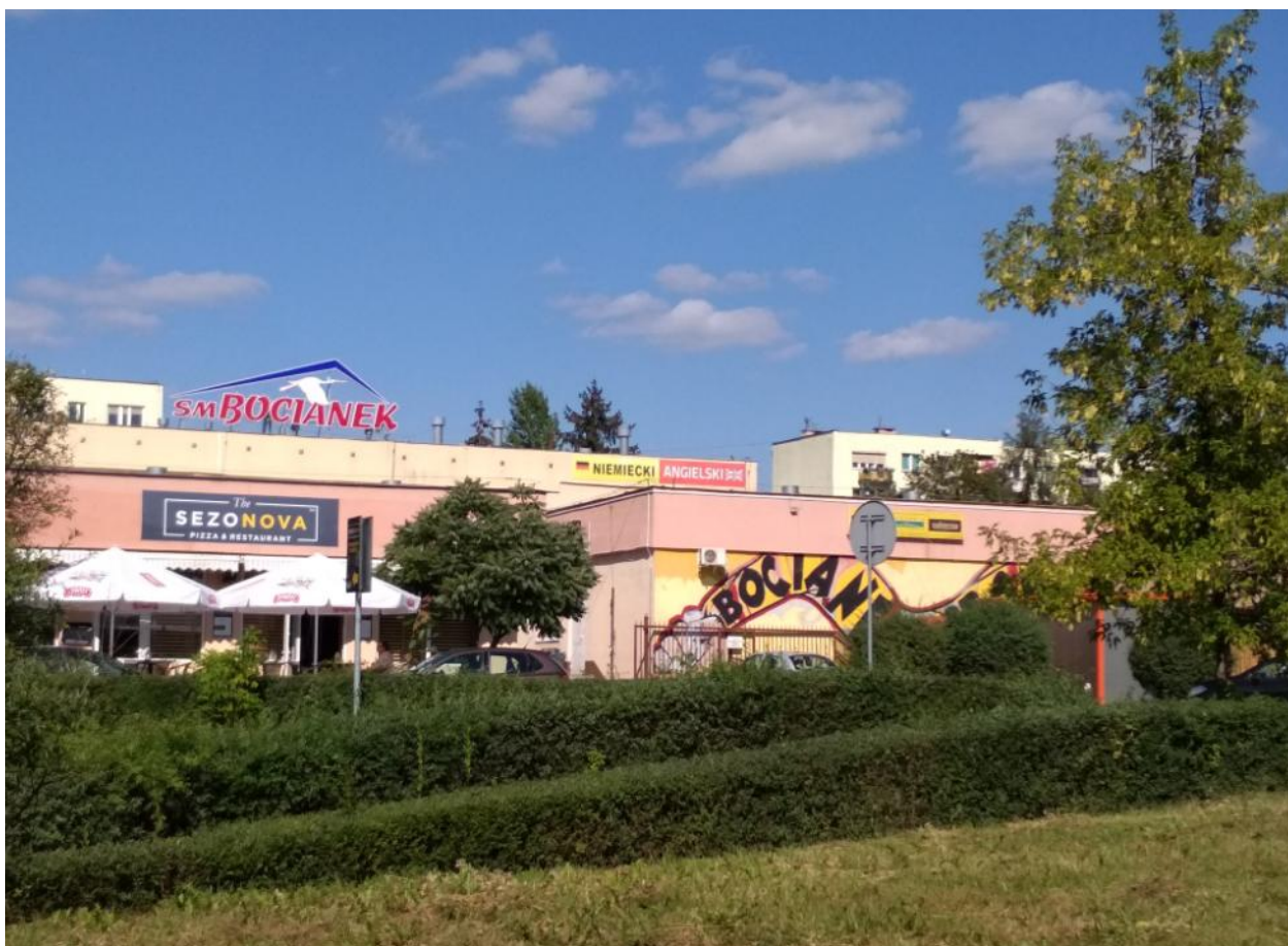
Fot. 8 Zabudowa usługowa przy Osiedlu Bocianek, [foto: wykonawca Raportu, sierpień 2018]
