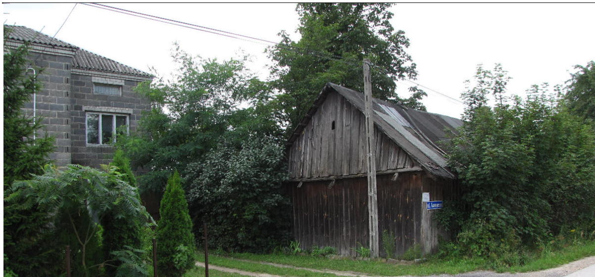
Fot. 81 Budynek przeznaczony do rozbiórki usytuowany w km 10+950 projektowanej drogi S 74 według przebiegu wariantu „IIA” „IIA 1 ”
