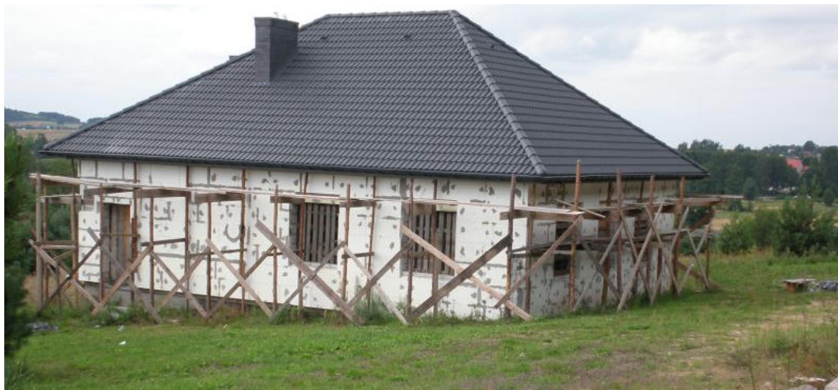
Fot. 80 Budynek przeznaczony do rozbiórki usytuowany w km 10+200 projektowanej drogi S 74 według przebiegu wariantu „IIA” i „IIA 1 ”
