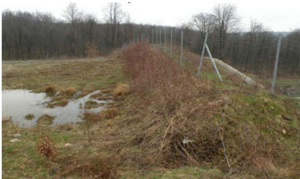
Fot. 76 Przykład wału ziemnego na przejściu górny; źródło „Projektowanie przejść dla zwierząt” dr Sabina Pierużek – Nowak i dr. Inż. Robert W. Mysłajek; Poznań 2010r.
