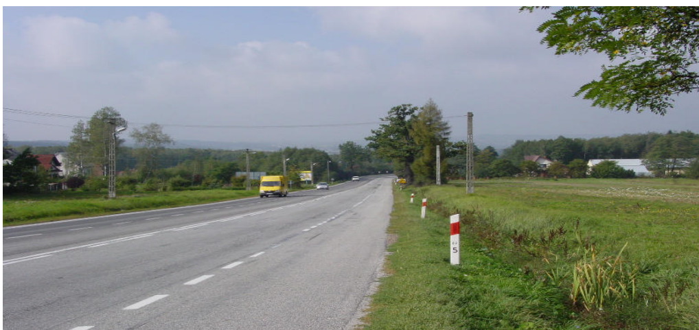
Fot. 8 Pola uprawne i łąki w rejonie przecięcia wariantu „I” i „IV” - km ok. 04+600 z istniejącą drogą krajową nr 74
