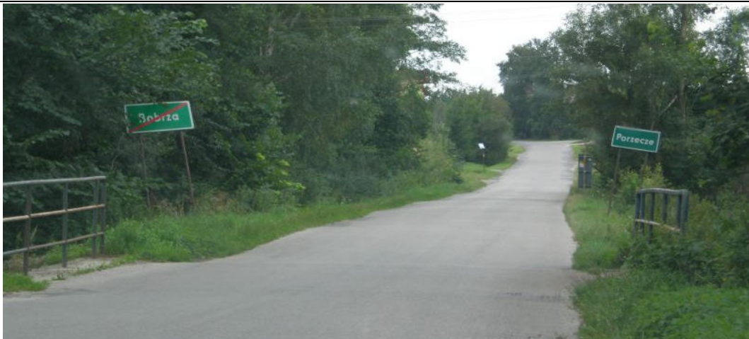
Fot. 22 Widok na most na rzece Ciemnicy w ciągu istniejącej drogi powiatowej 0286T - Miejsce przecięcia z projektowaną drogą ekspresową w wariantach „II”, „IIA”, „IIA 1 ” i „III” w km ok. 09+000
