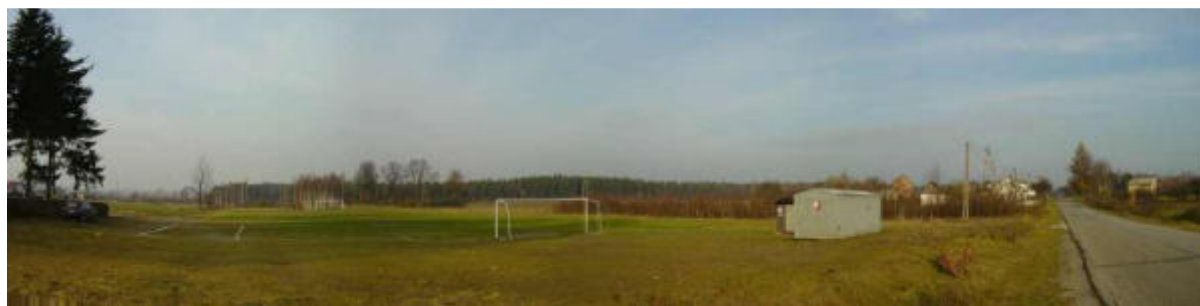
Fot. 74 Boisko przy zabytkowym cmentarzu w Mniowie, w tle zabudowania Gajówki – planowany wariant „I” przebiega za boiskiem. Nad istniejącą drogą będzie przechodzić planowana inwestycja, po wiadukcie WD-2 (wariant „I”)
