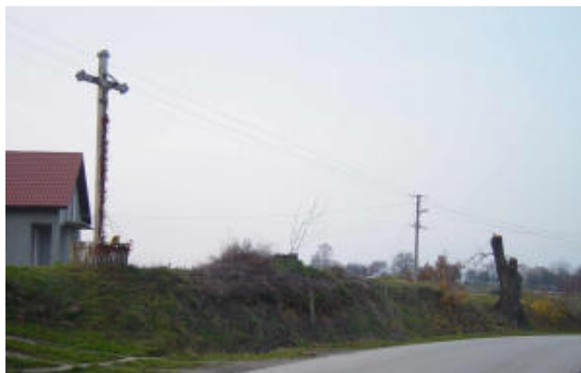
Fot. 47 Pozostałość po dębie przy posesji nr 37 w Pępicach (nr ewid. 339)
