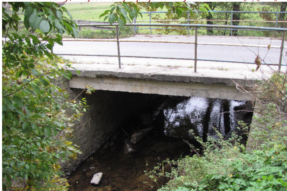
Fot. 37 Istniejący obiekt mostowy na rzece Ciemnicy
