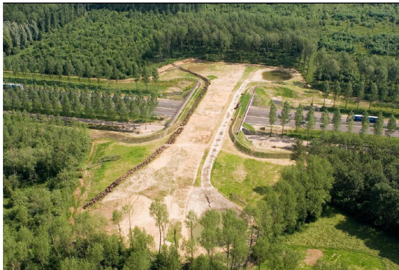
Fot. 77 Przejście górne – umożliwiające przejście dla płazów; źródło: Wildlife habitat Connectivity – Innovative Tools and Techniques, ICOET – Adopting to Change, J. Kintsch, C. Bailey
