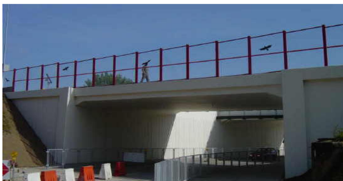
Fot. 79 Przykład przejazdu i przejścia pod drogą szybkiego ruchu
