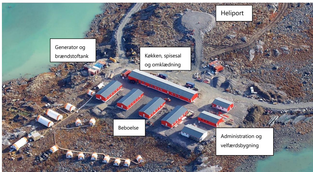
Figur 9.5: Billede af den modificerede lejrby, som oprindeligt blev anvendt under etablering af Paakitsoq vandkraftværk.
