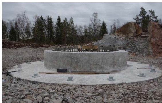
Figur 3.3 Bergsfundament
