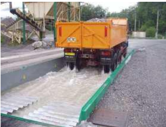
Exemple de station de lavage des bennes à béton en site restreint :
