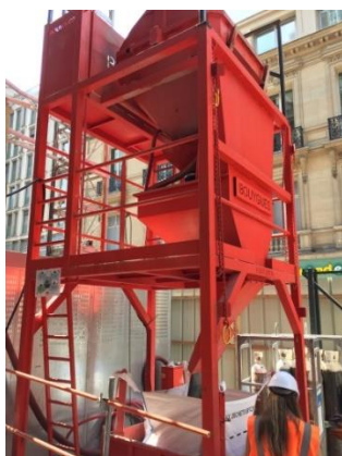
Exemple de station de lavage des bennes à béton en site restreint :
