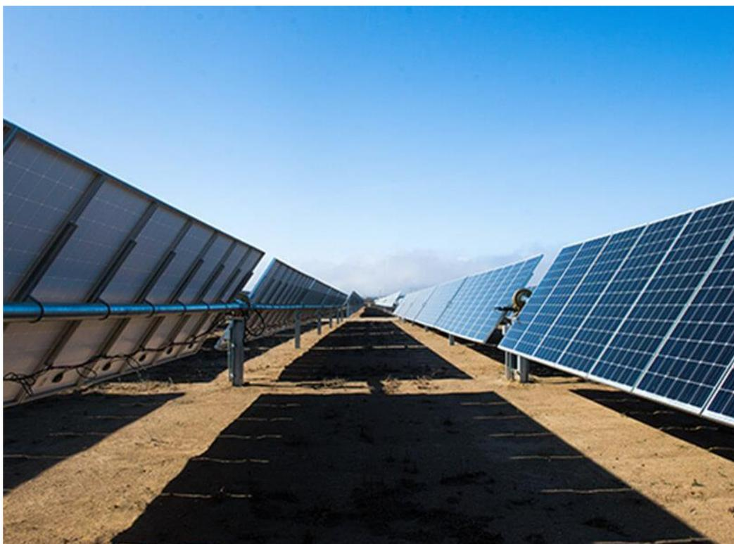
*Ilustración 4 - Seguidor 1V Nextracker*
