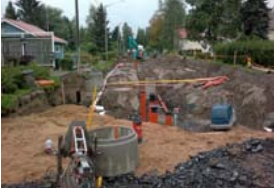
Kuva 8-17. Putkikaivanto ja tietyömaa omakotialueella. Siirtolinjojen putkiosuukien rakentaminen voidaan toteuttaa osittain samaan aikaan kadun kunnostuksen kanssa kuten kuvassa.
