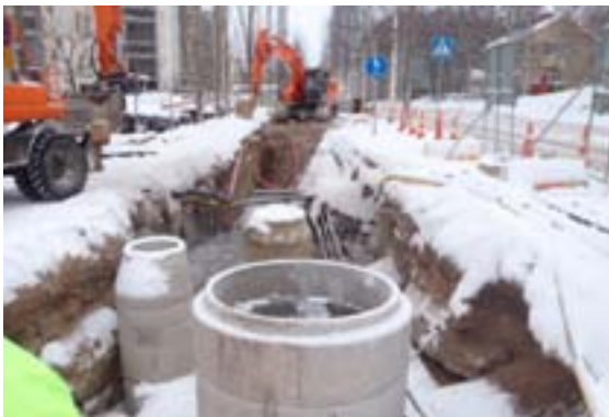
Kuva 8-19. Putkityömaa kevyenliikenteenväylällä talviaikaan.
