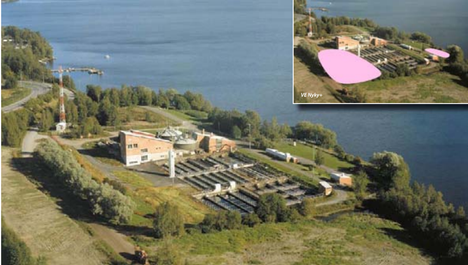
Kuva 9-4. Raholan jätevedenpuhdistamo nykytilassa. Kuvassa hiekanerotus sijaitsevat ylhäällä oikealla, jäteveden esiselkeytys altaat keskellä rakennusten edessä, ilmastusaltaat keskimmissä allasrivistössä ja jälkiselkeytysaltaat kuvassa edessä. Ilmastuksen kompressorirakennus on ilmastusaltaiden vieressä järven rannalla. Lietteenkäsittelytilat, huolto- ja hallintorakennukset sijaitsevat ylhäällä altaiden takana.
