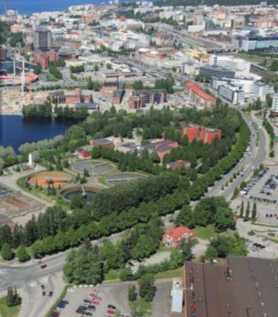
Kuva 9-2. Viinikanlahden jätevedenpuhdistamo nykytilassa. Kuvassa jäteveden tulopumppaus ja hiekanerotus sijaitsevat ylhäällä oikealla (pyöreiden altaiden yläpuolella), jäteveden esiselkeytys (pyöreät altaat) keskellä, ilmastusaltaat (suorakaiteen malliset ruskeat altaat) vasemmalla alhaalla ja jälkiselkeytysaltaat niiden vieressä järven puolella. Ilmastuksen kompressorirakennus on ilmastusaltaiden vieressä tien puolella. Lietteenkäsittelytilat, huolto- ja hallintorakennukset sijaitsevat oikealla ylhäällä pyöreiden altaiden vieressä.
