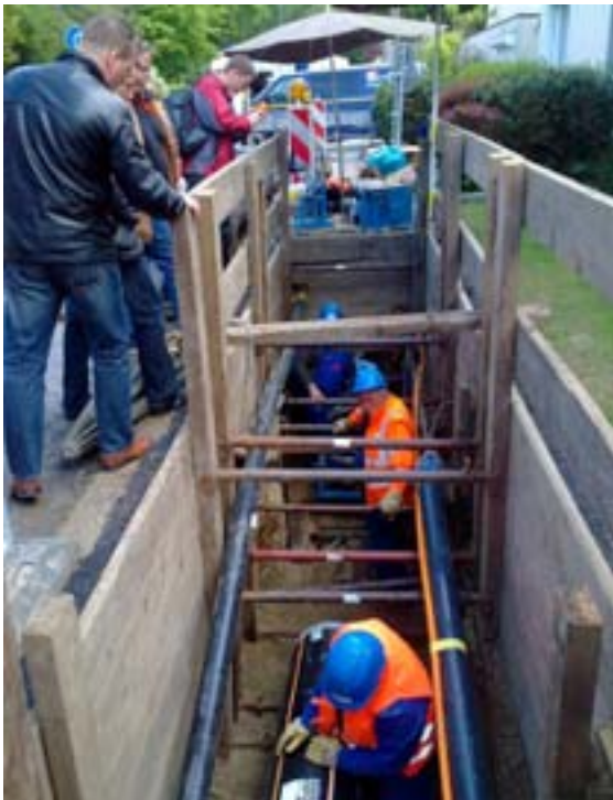
Kuva 8-18. Työskentelyä tuetussa putkikaivannossa kaupungin keskustassa.
