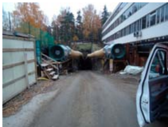
Kuva 8-8 Esimerkkikuvia valmiista ajotunnelien suuaukoista ja suuaukosta rakentamisen aikana. kuvissa näkyvät myös rakentamisen aikana käytettävät puhaltimet (kuvat: Kari Äikäs /Saanio & Riekkola Oy, Kalle Hollmén / Saanio & Riekkola)
