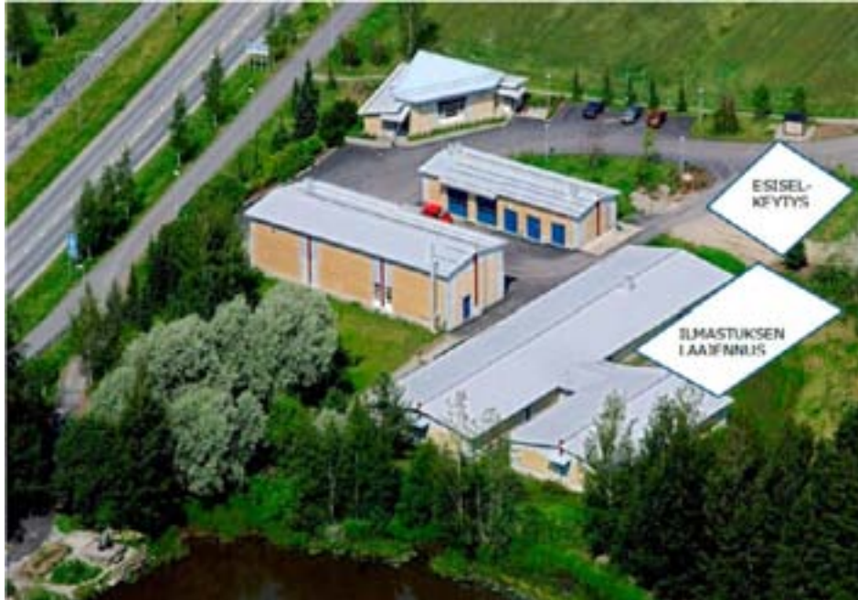
Kuva 9-6. Lempäälän jätevedenpuhdistamo ennen saneerausta. Kuvassa esi- ja lietteenkäsittelytilat sijaitsee vasemmalla etualalla olevassa suorakaiteen muotoisessa rakennuksessa, sen takana olevassa rakennuksessa sijaitsee tulopumppaamo ja kompressoriasema, ilmastusaltaat (ml. kuvan oton jälkeen rakennettu laajennus) ja jälkiselkeytysaltaat sijaitsevat etualan kaksiosaisessa rakennuksessa. Jäteveden esiselkeytys on rakennettu kuvan ottamisen jälkeen ilmastuksen taakse. Valvomo- ja toimistorakennus on kolmionmallinen rakennus kuvan taka-alalla.
