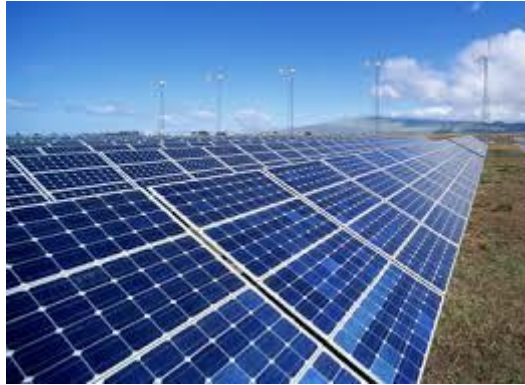
Figure 6 : Type d'installation fixe
