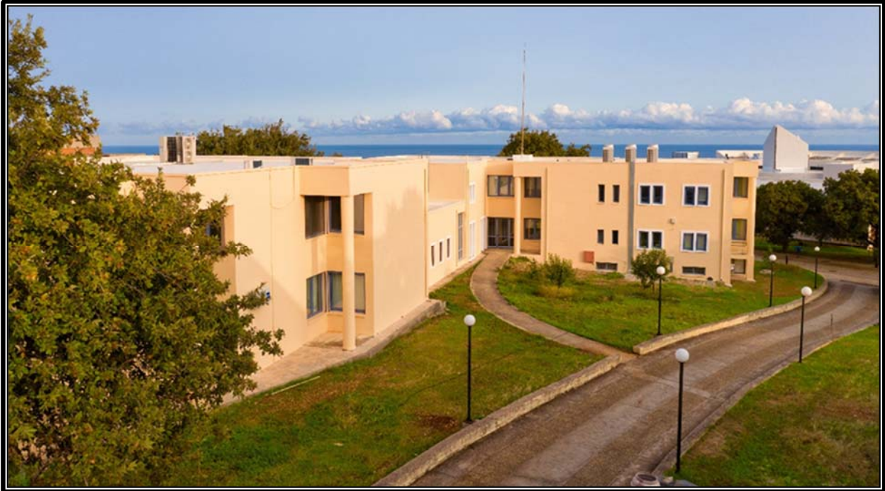
Εικόνα 14.13: Ενδεικτική άποψη υφιστάμενων εγκαταστάσεων
