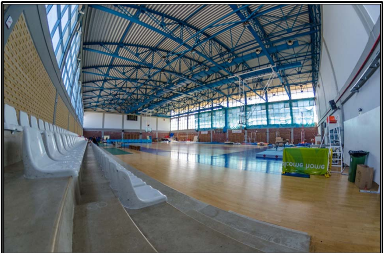
Εικόνα 14.8: Ενδεικτική άποψη υφιστάμενων εγκαταστάσεων (γυμναστήριο)
