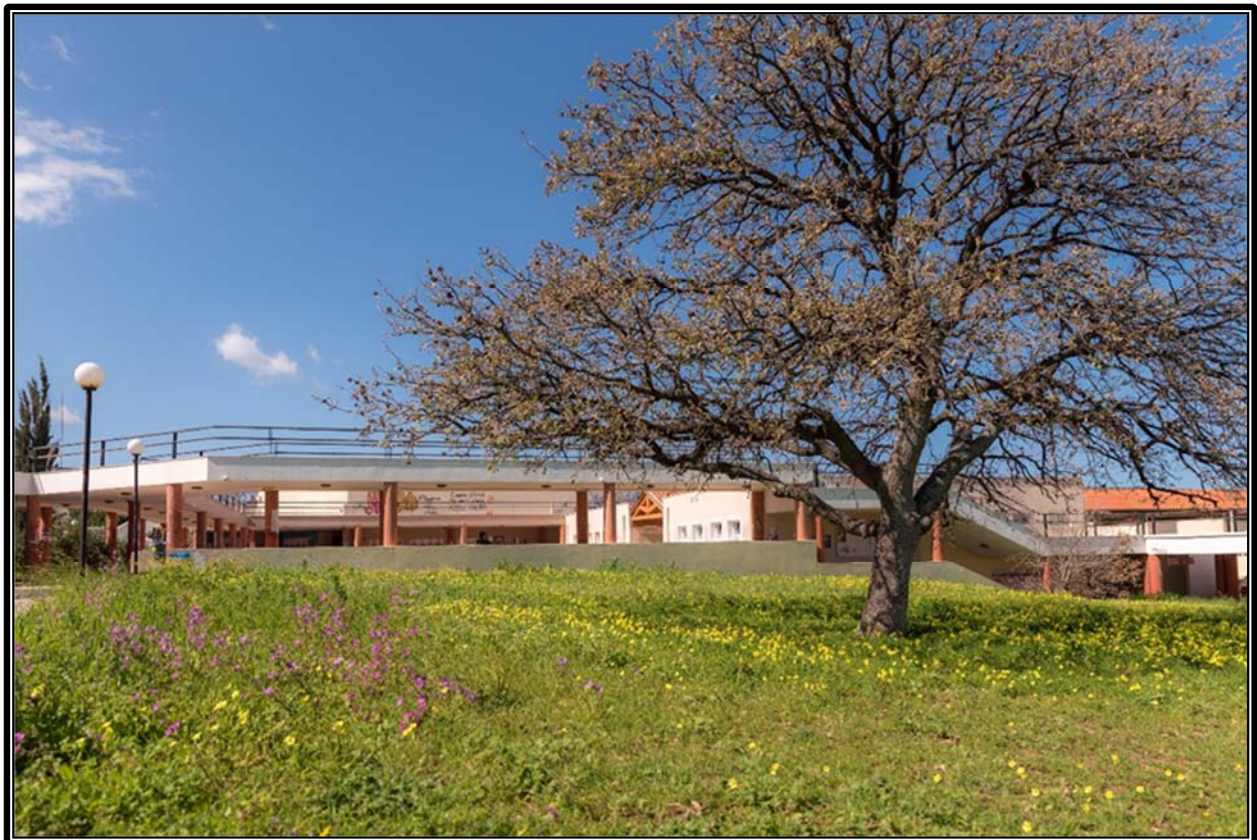
Εικόνα 14.12: Ενδεικτική άποψη υφιστάμενων εγκαταστάσεων
