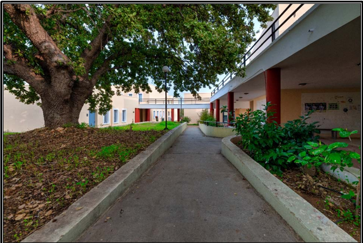
Εικόνα 14.14: Ενδεικτική άποψη υφιστάμενων εγκαταστάσεων
