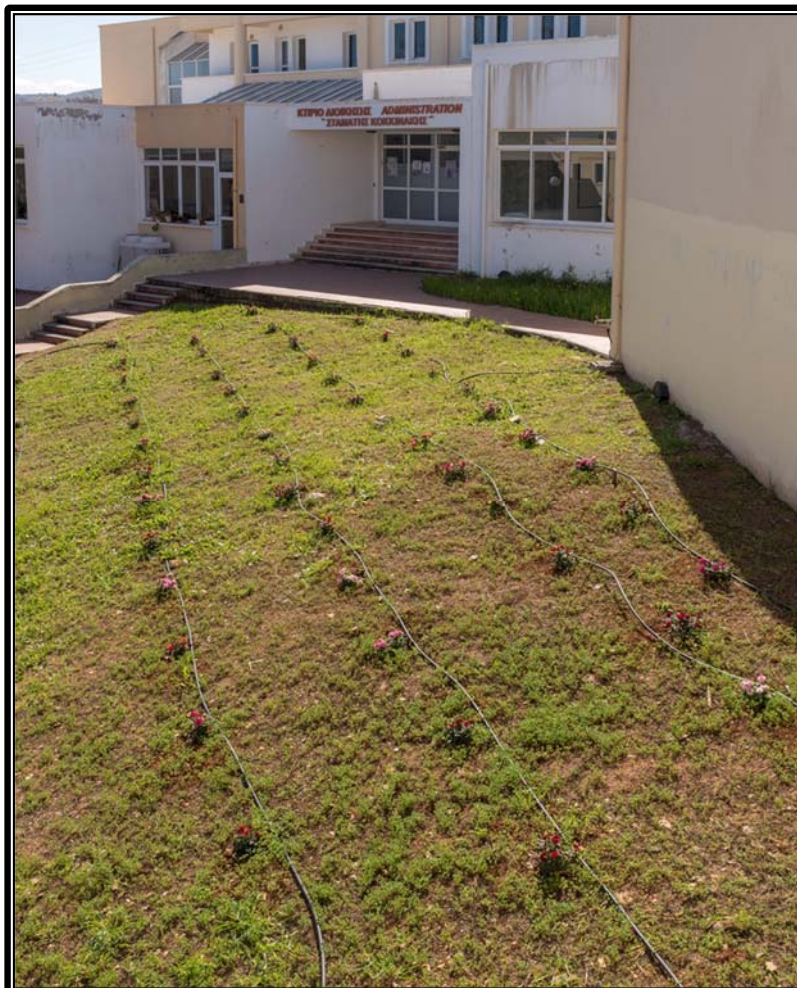
Εικόνα 14.4: Ενδεικτική άποψη υφιστάμενων εγκαταστάσεων (κτίριο Διοίκησης)
