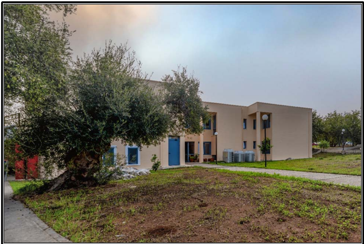
Εικόνα 14.16: Ενδεικτική άποψη υφιστάμενων εγκαταστάσεων
