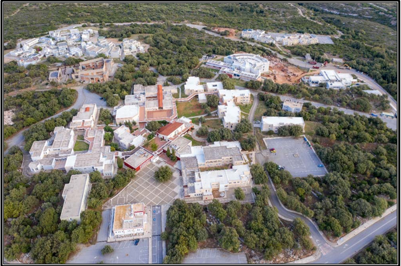
Εικόνα 14.1: Αεροφωτογραφία των εγκαταστάσεων προς Βορρά
