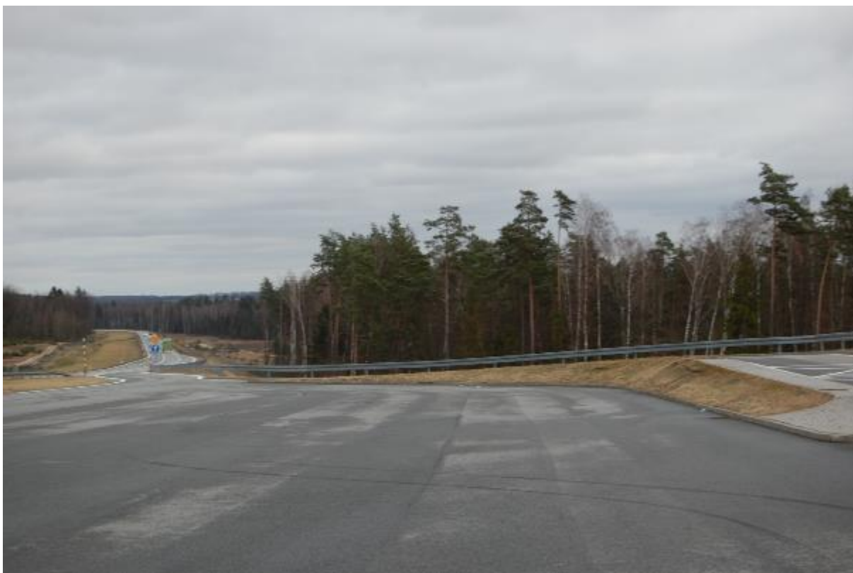
Zdjęcie 7 Obwodnica na Odcinku 2 – kulminacja Gór Krępskich, miejsce na MOP (około km 3+000 C: 9+180)
