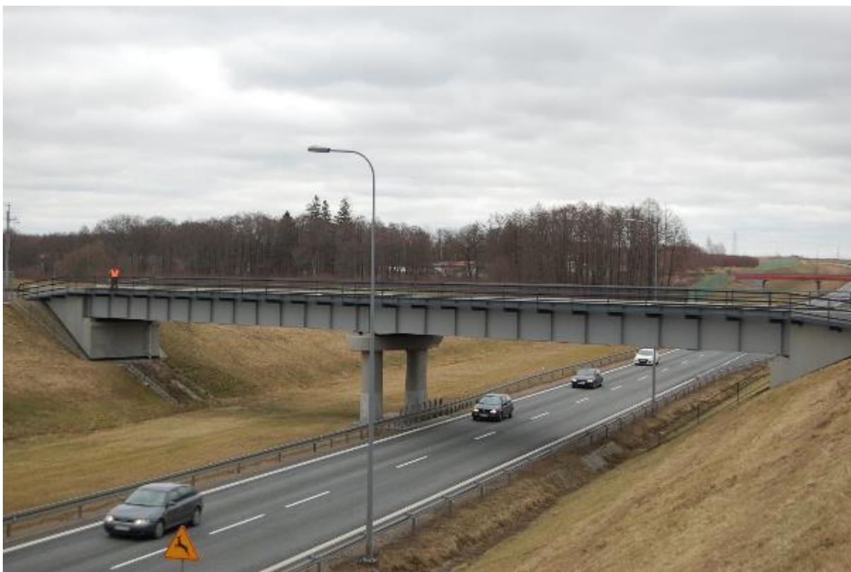
Zdjęcie 2 Początek Odcinka 1 – wykop w rejonie Widzina (około km 0+400 C: 3+000)
