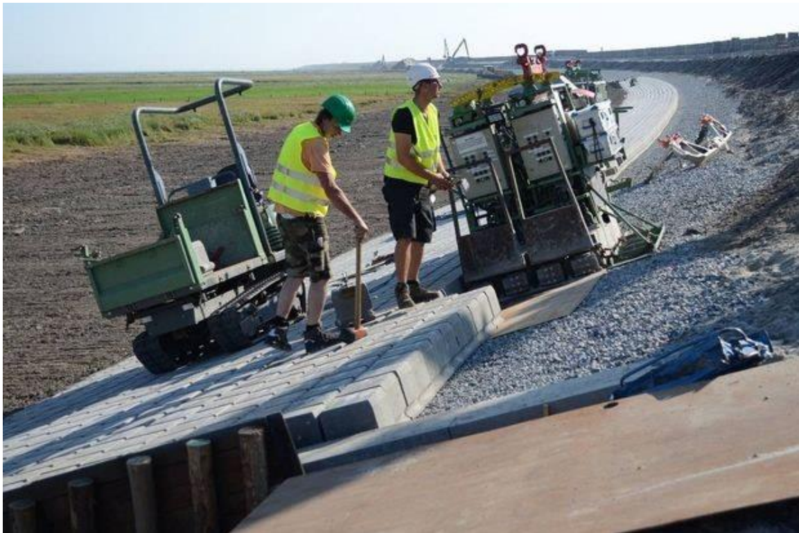
Afbeelding 3.8 Plaatsen van zetstenen op de Lauwersmeerdijk (bron: www.wetterskipfryslan.nl )
