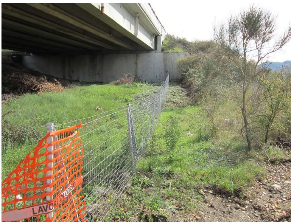
Figura 4-6. Spalla lato Bari
