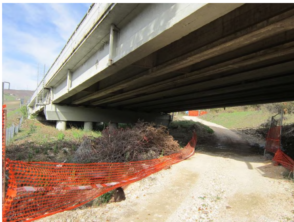
Figura 4-7. Area dove verrà predisposto il cantiere
