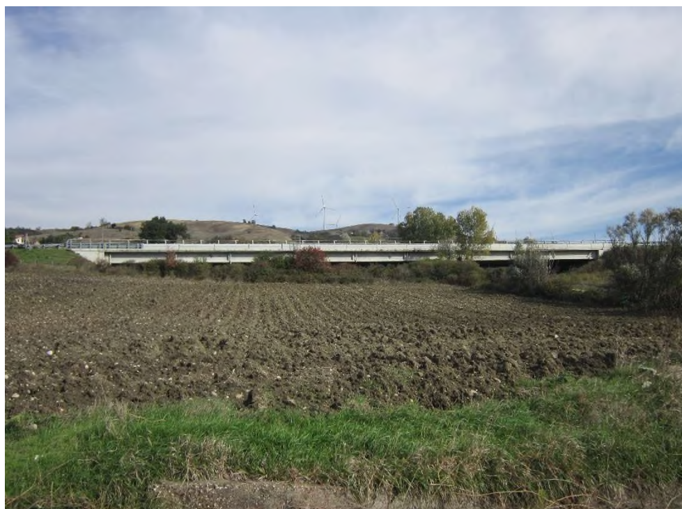
Figura 4-1. Paesaggio a sud (a valle) del viadotto Leone
