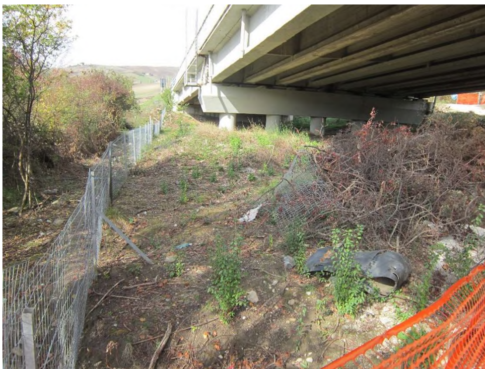
Figura 4-8. Condizioni della vegetazione e del suolo sotto al viadotto Leone
