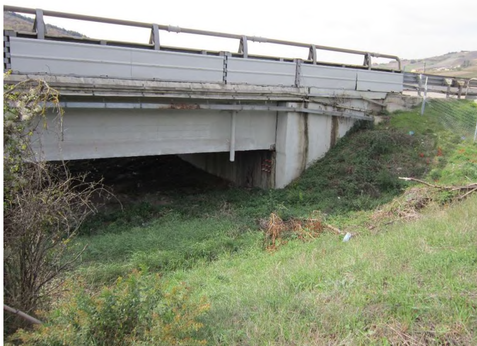
Figura 4-3. Spalla lato Napoli
