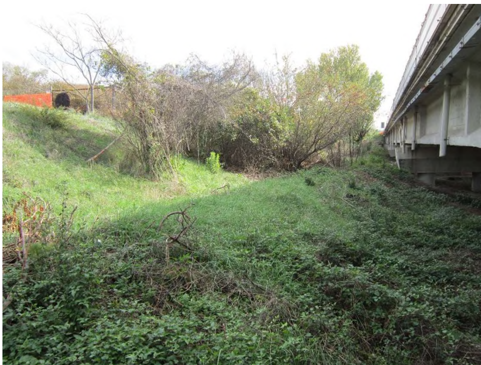
Figura 4-10. Condizioni della vegetazione e del suolo sotto al viadotto Leone
