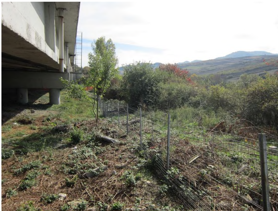
Figura 4-9. Condizioni della vegetazione e del suolo sotto al viadotto Leone
