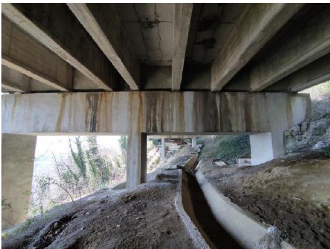
Figura 2-3. Dettaglio impalcato – travi in C.A.P e pile
