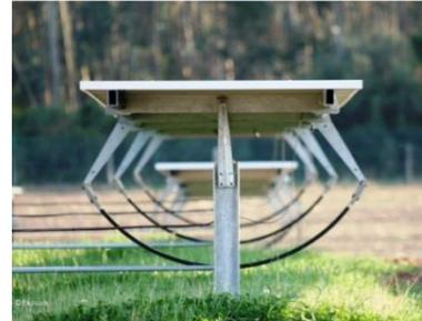
Figure 10 : Structure mono-axiale
