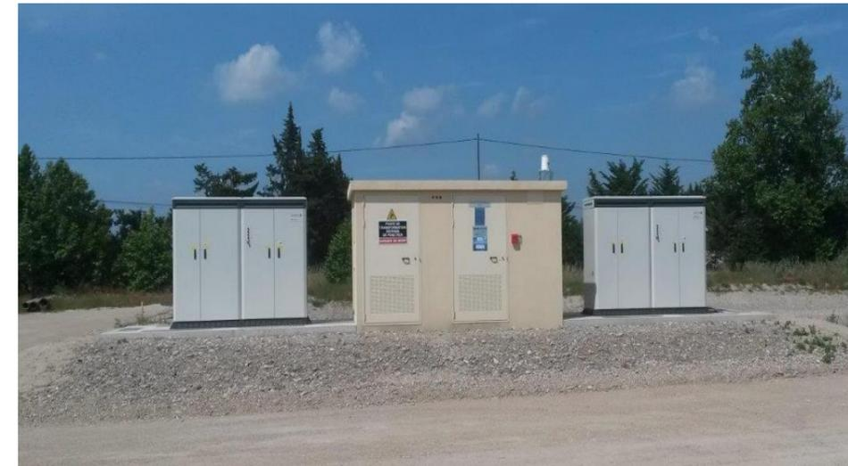
Figure 61 - Exemple de poste onduleurs + transformateur non-enterré
