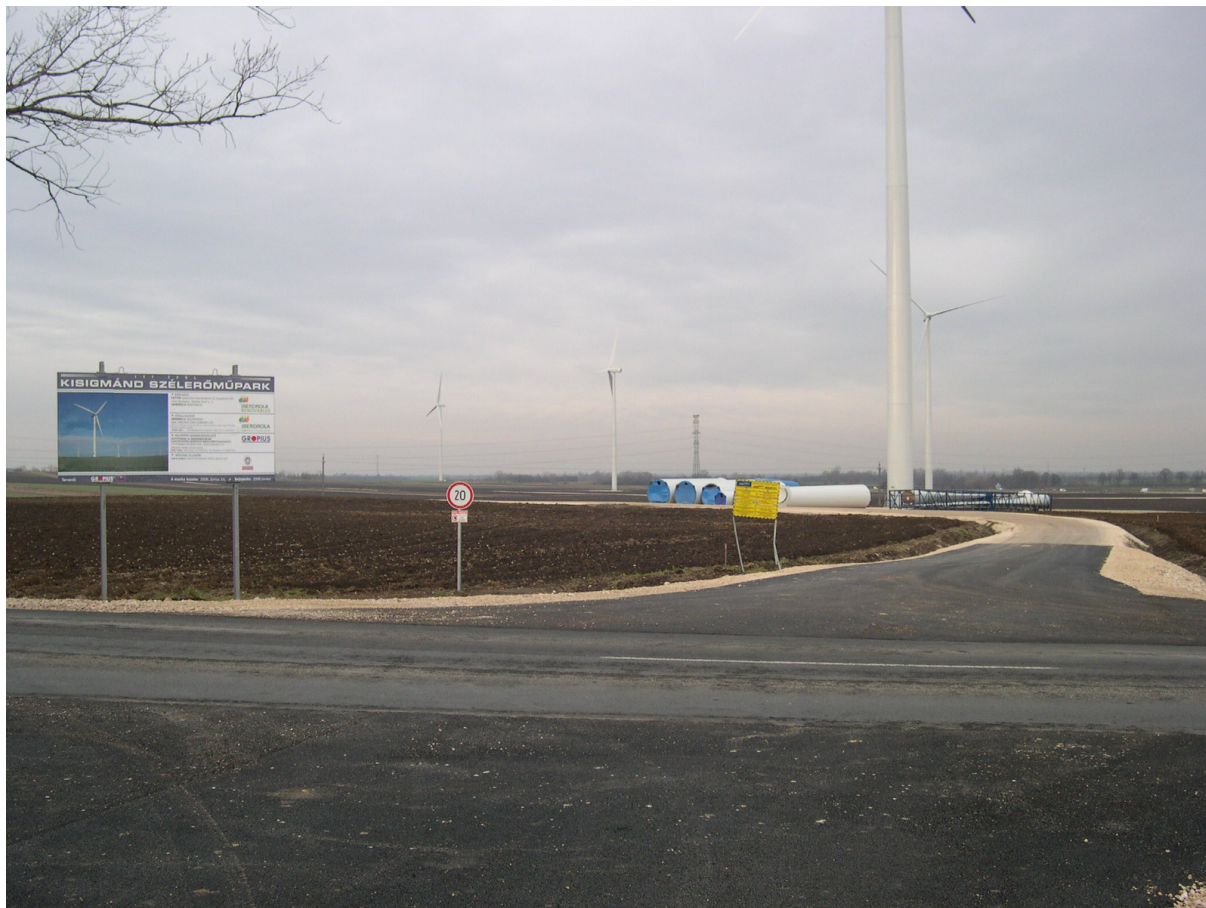
Joonis 36. Näide (Ungari) tuulikupargi ehitamiseks vajaliku tee mahasõidust maanteelt (allikas: Iberdrola).
