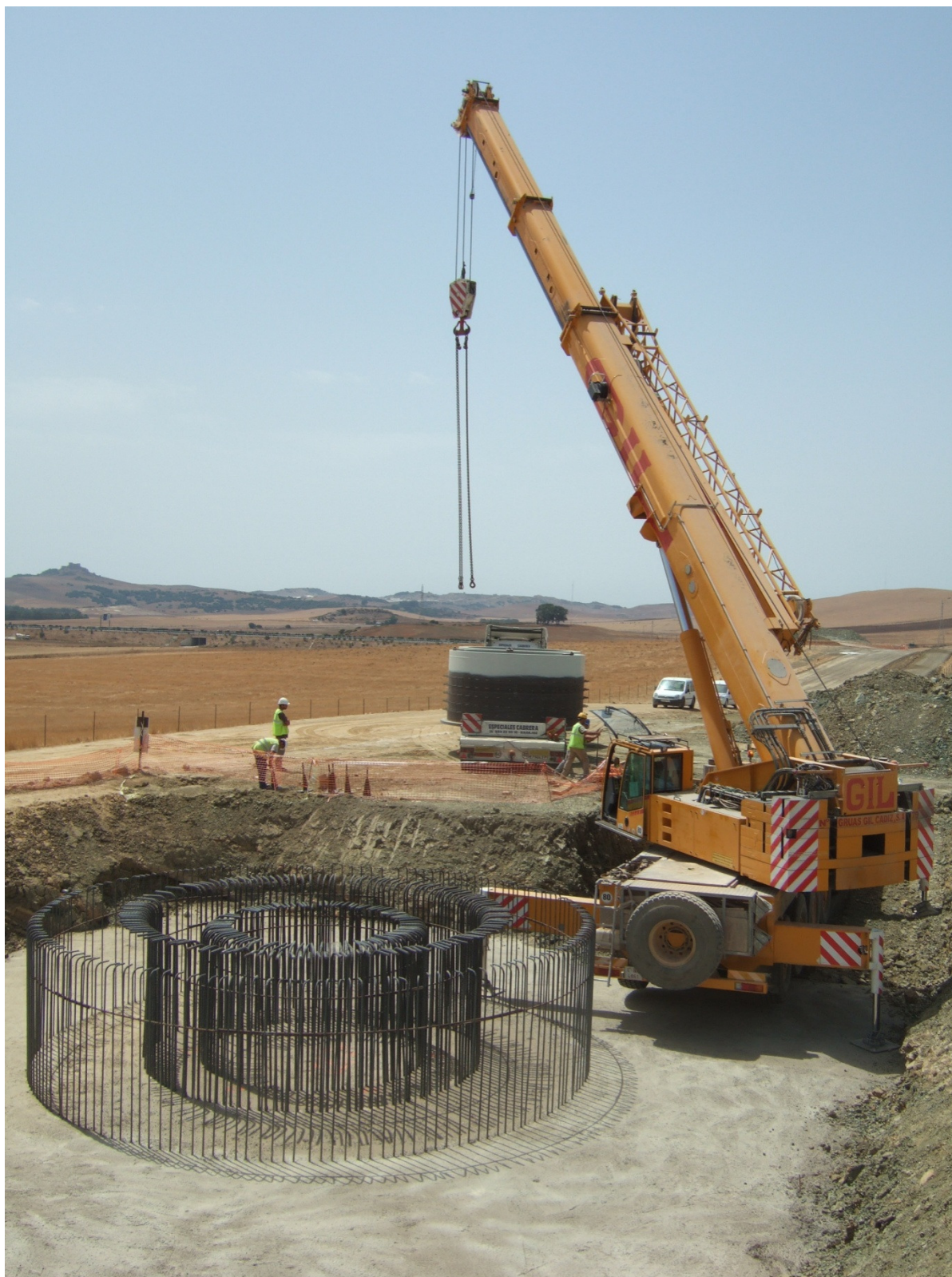
Joonis 28. Näide tuuliku vundamendi ehitusest (allikas: Iberdrola).
