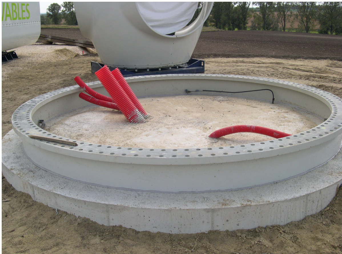
Joonis 29. Näide tuuliku vundamendist enne sellele tuuliku torni püstitamist (allikas: Iberdrola).
