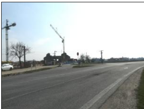
Pohľad na výstavbu bytových domov v katastrálnom území MČ Jarovce v blízkosti diaľnice v km cca 1,3 - obidva varianty
