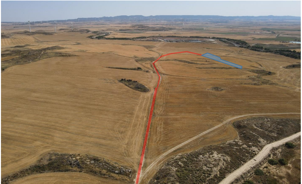
Fotografía 6: Vista de la zona de la zona de ubicación del aerogenerador SR-03 en zonas de cultivo. Se marca en azul la zona de ocupación de la plataforma y en rojo el acceso hasta la misma. Al fondo los parques eólicos de rabosera, santo Domingo de Luna, los Monlora, y las sierras de Erla.
